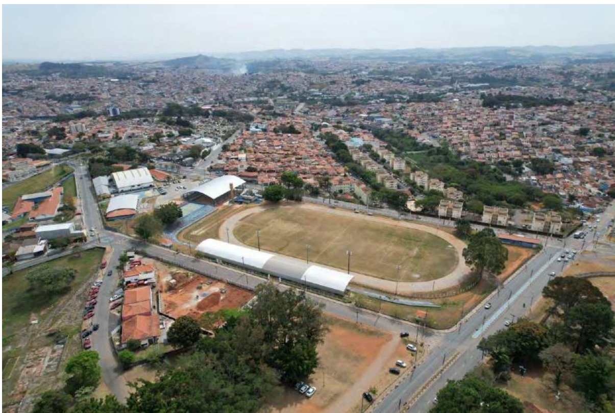
Fotos 01 a 13: Fotos realizadas no estádio antes da reforma.
