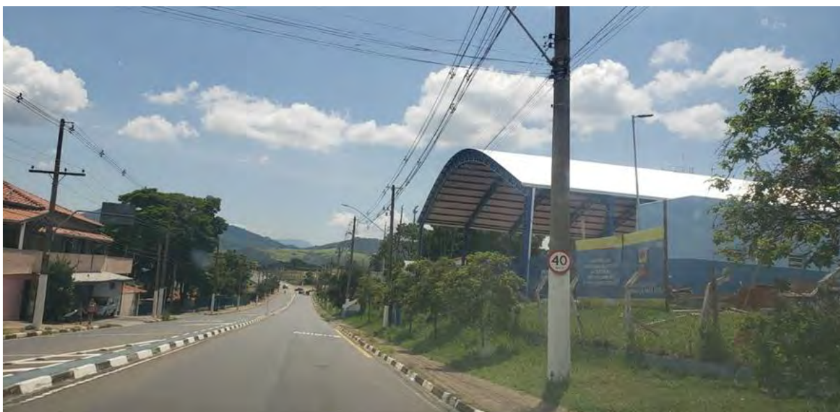
Foto 15: Via no entorno do Estádio.
