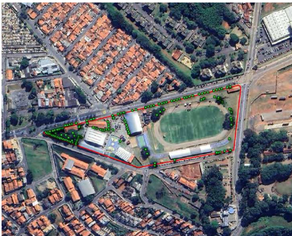
Figura 21: Gleba municipal do estádio municipal, com levantamento das árvores isoladas (nativas e exóticas), sendo exóticas em sua maioria.
