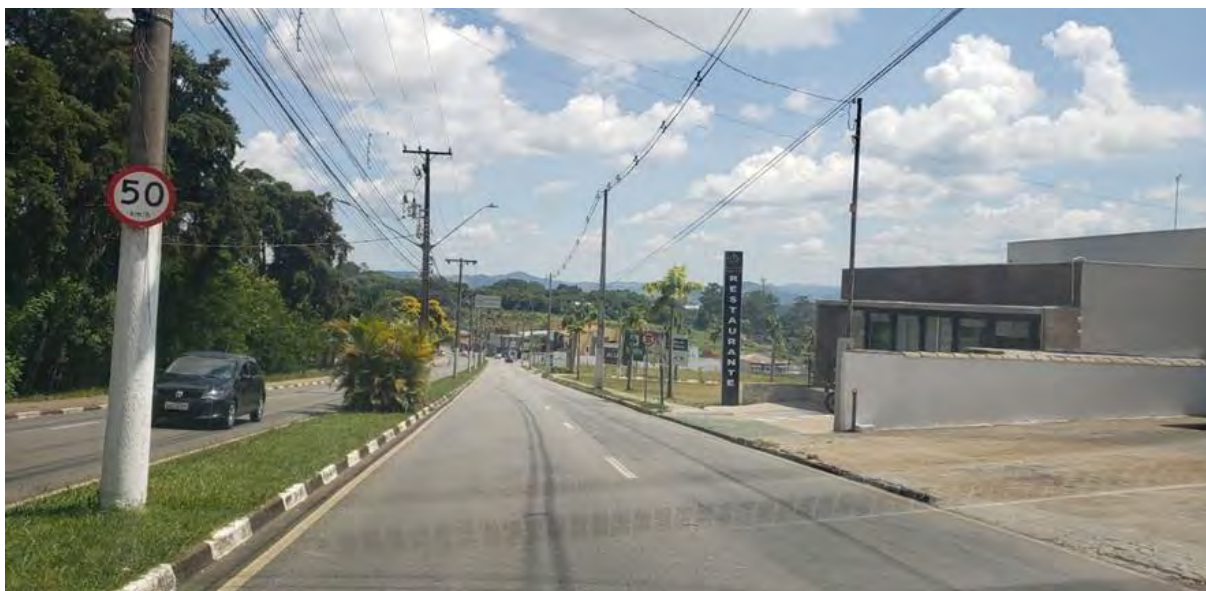
Foto 01: Acesso ao Estádio pela Av. Norte Sul / Rua Felício Helito.
