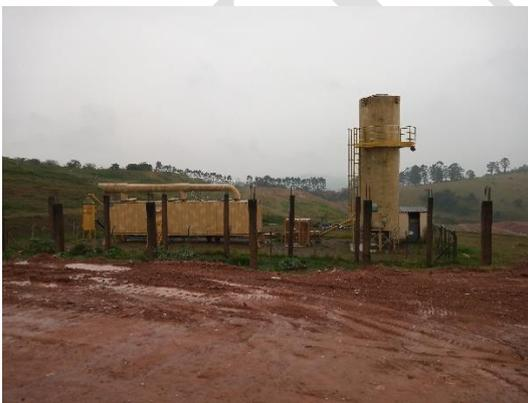
Figura 170 - Extração forçada de gás.
