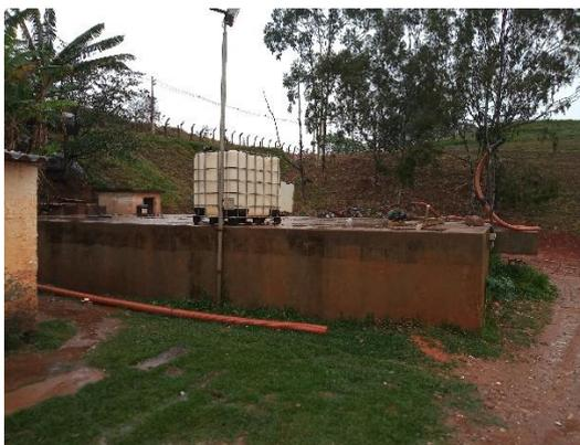
Figura 172 - Armazenamento de chorume para posterior destinação final
