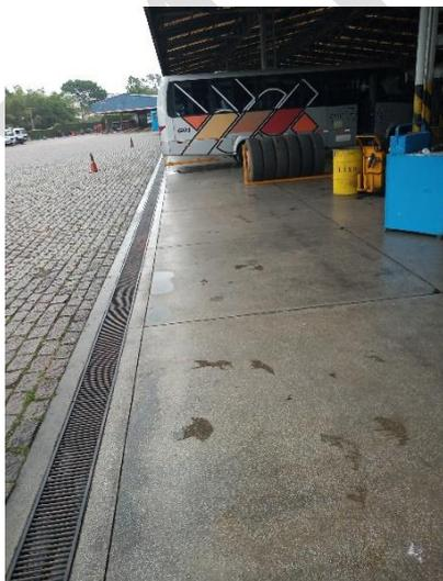
Figura 141 - Coleta de água das áreas de manutenção para destinação a Caixa Separadora de Água e Óleo.
