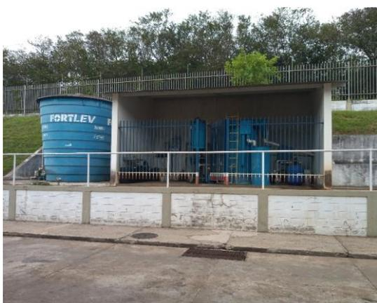
Figura 133 - Sistema de captação e reuso da água da lavagem externa.
