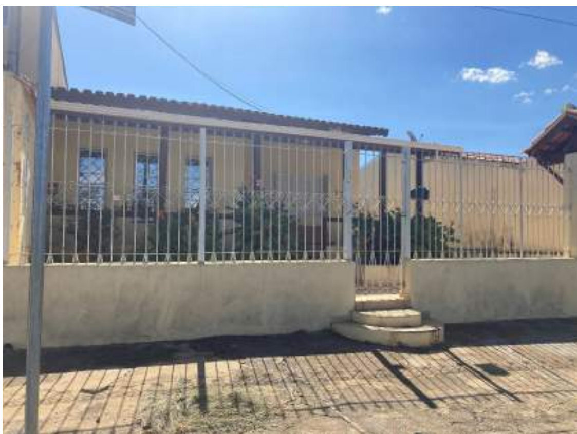
Figura 22. Residencial unifamiliar – Av. Antônio Pierotti.
