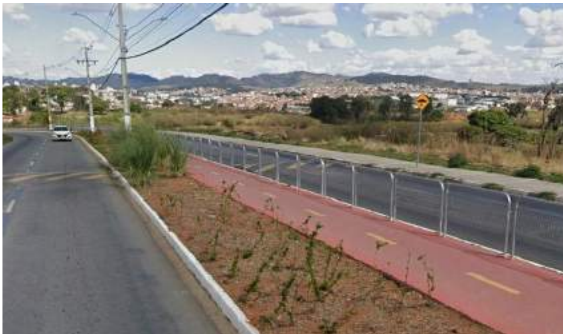
Figura 13. Vista geral da Av. Atílio Menin com ciclovía no canteiro central.
