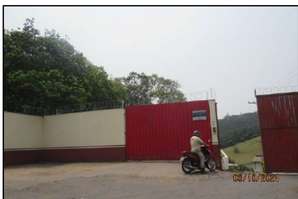
Foto 8. Galpão de serviços (Norte da área de estudo).
