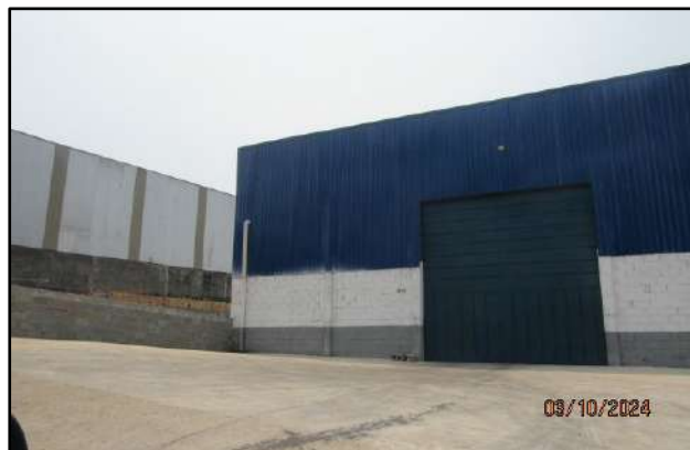
Foto 7. Galpão de serviços (Norte da área de estudo).
