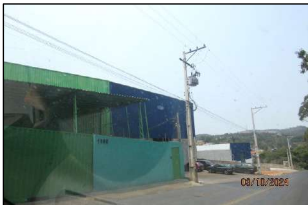
Foto 6. Galpão de serviços (Norte da área de estudo).
