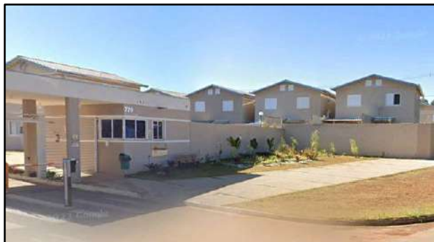
Foto 12. Condomínio ao Sul da área de estudo.
