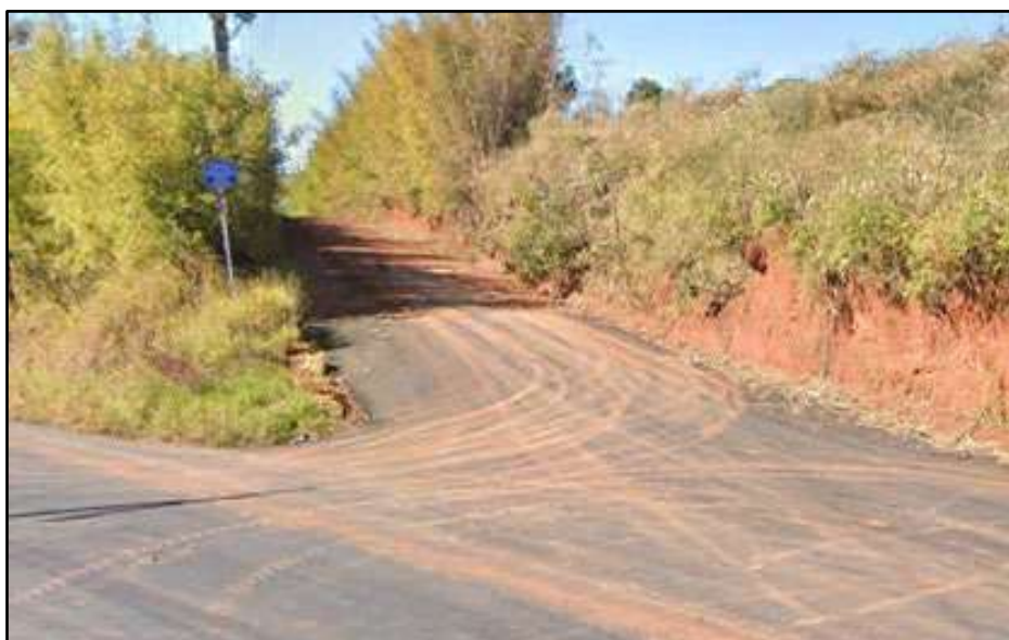
Foto 19. Estrada Municipal Jandyra Dantas Zandoná.
