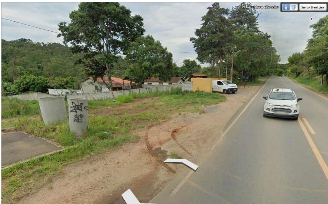
Localização da parada de ônibus. Não há abrigo, sinalização, iluminação. Fonte: o autor
