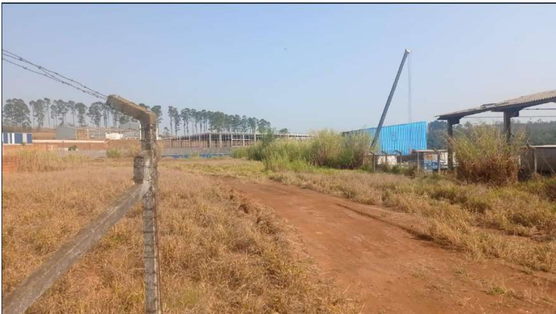
Vista geral da area interna do terreno
