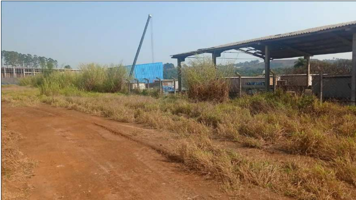
Vista geral da area interna do terreno
