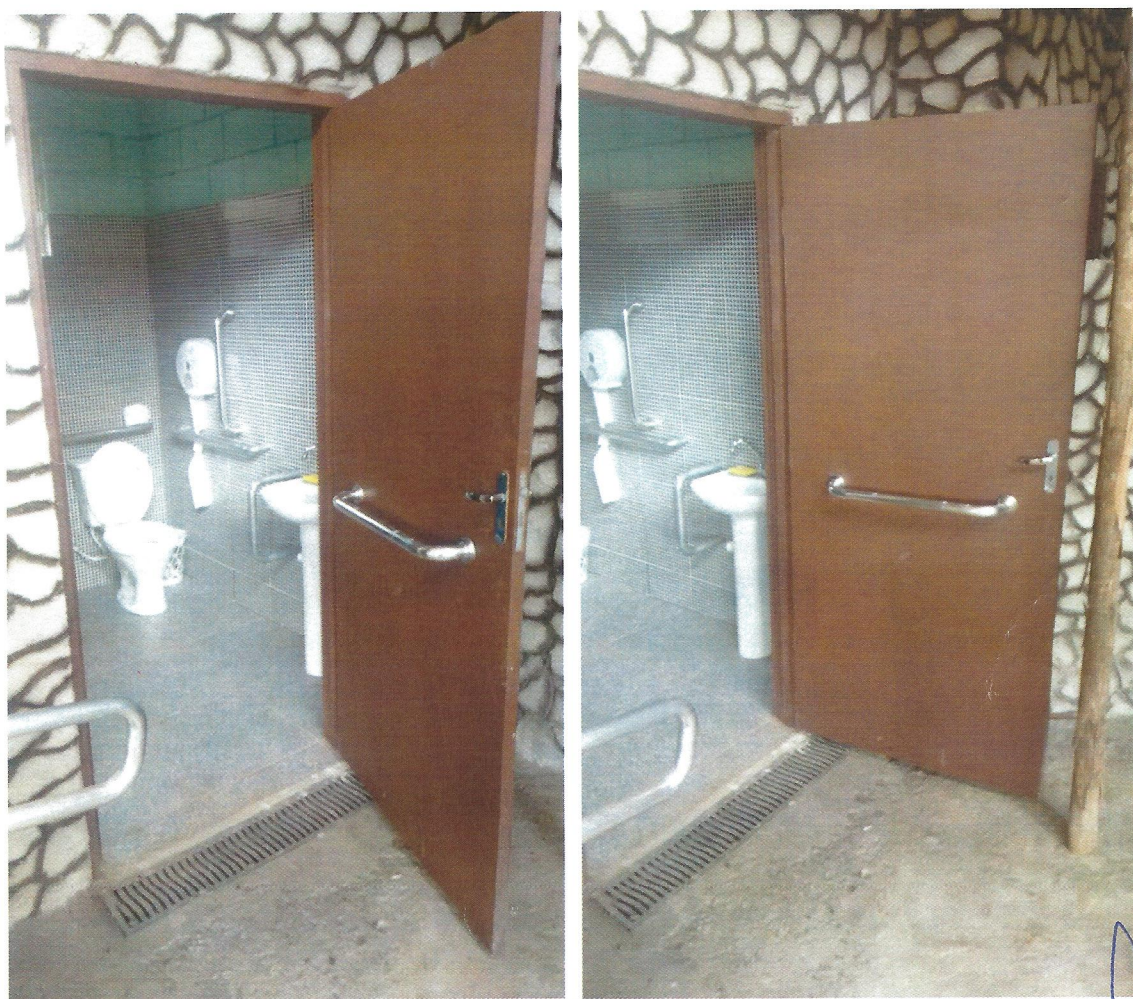
Vista Porta de Acesso ao Sanitário de PNE
