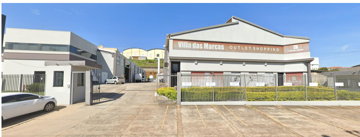
Figura 17 - Vista lateral direita, possível ver que a volumetria do empreendimento não destoa dos demais
