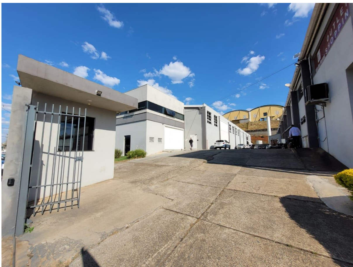
Figura 6 - Acesso e área de manobra do empreendimento
