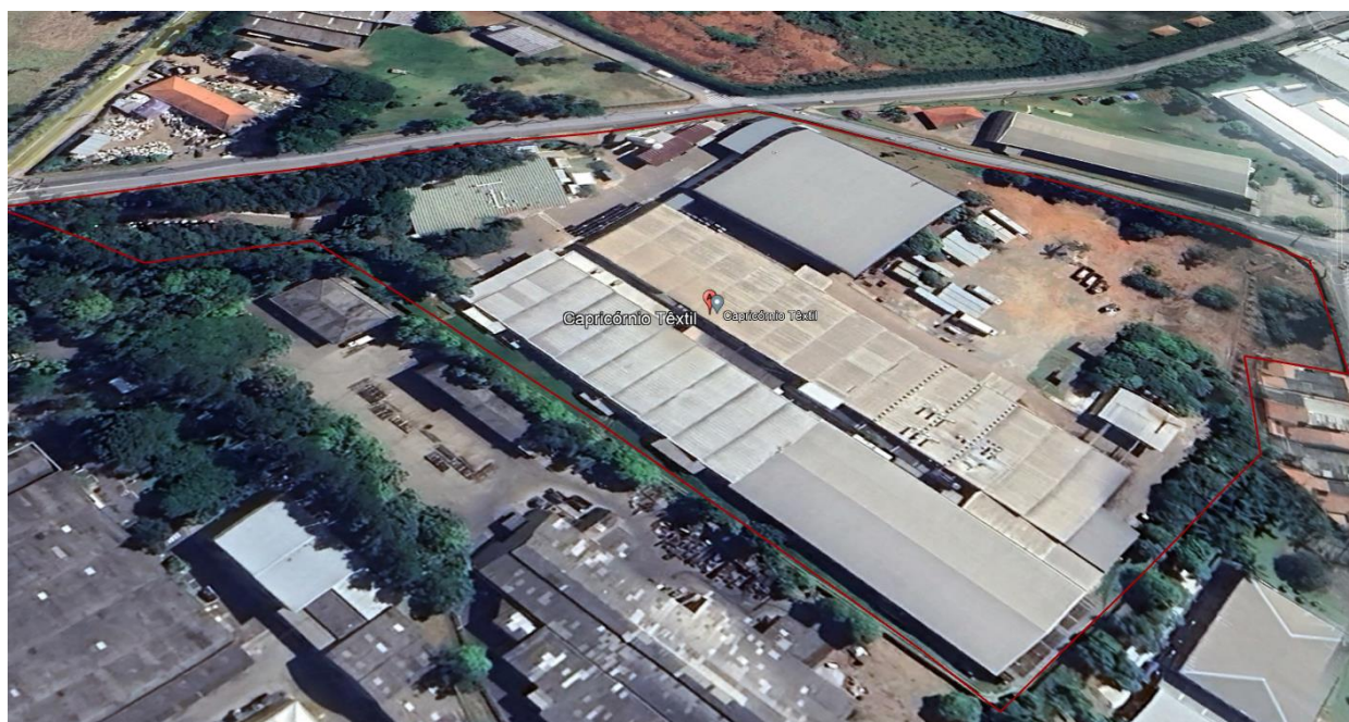
Figura 10: Empreendimento - ausência de sombreamento e ventilação para os demais imóveis.
