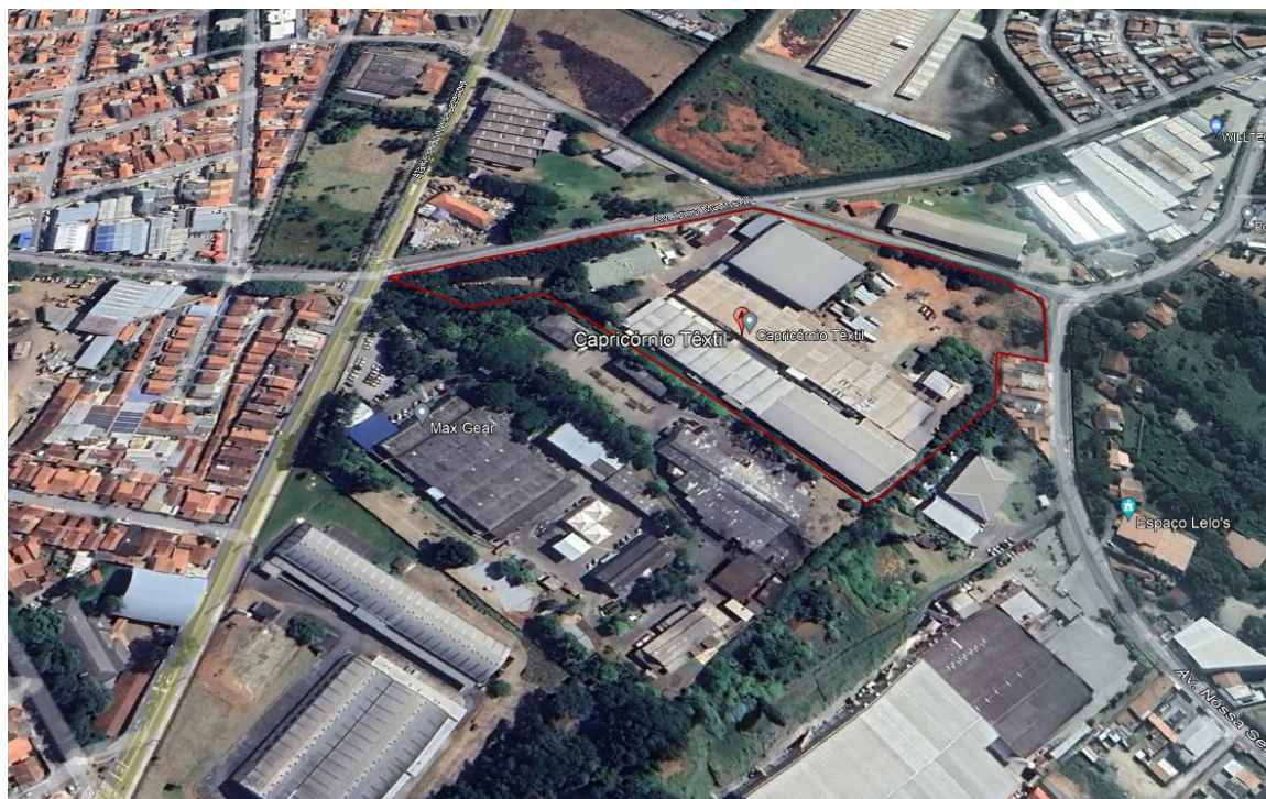
Figura 11: Ausência de arborização nas ruas onde se localiza o empreendimento.
