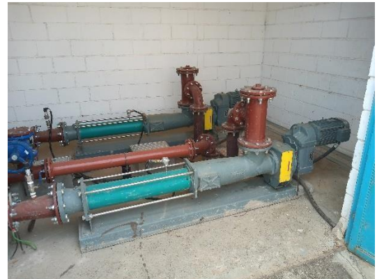
Fonte: AMPLAR engenharia. Figura 107 - EEE – Portal da Serra
