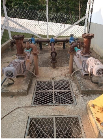
Fonte: AMPLAR engenharia. Figura 102 - EEE – Vila Real
