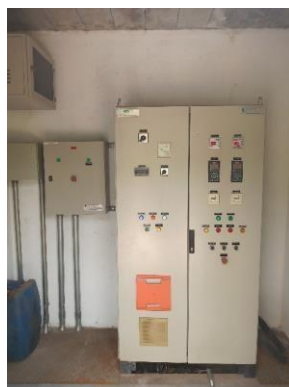
Figura 89 -Elevatória com 2 bombas sendo 1 reserva.
