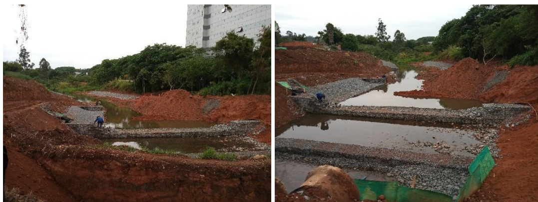
Figura 180 – Obra de implantação de sistema de retenção de sólidos a montante do Lago do Taboão
