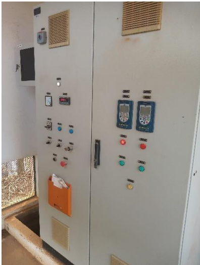
Fonte: AMPLAR engenharia. Figura 104 - EEE – Bragança F
