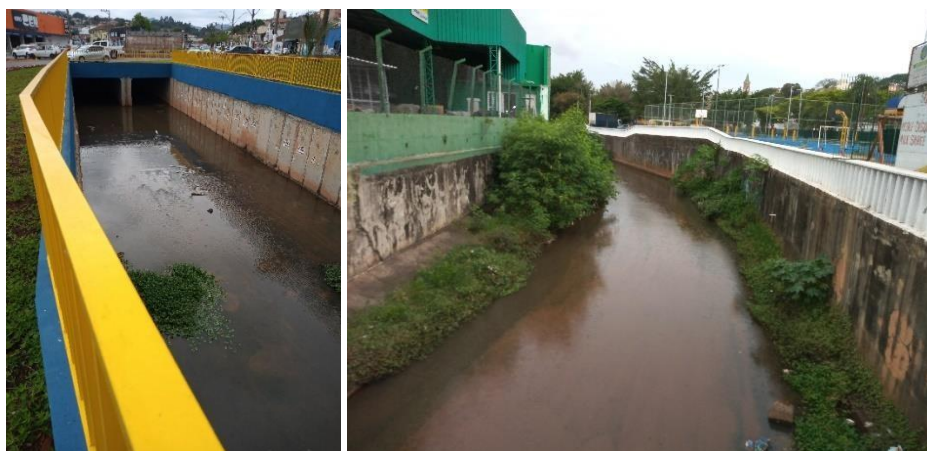
Fonte: Amplar Engenharia - Figura 189 – Obra Executada no Ribeirão Lavapés
