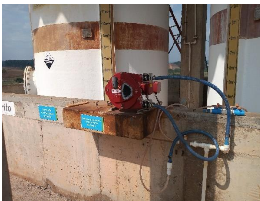
Figura 126 - Dosadora de Hipoclorito de Sódio (reserva em manutenção).
