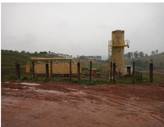
Figura 170 - Extração forçada de gás.
