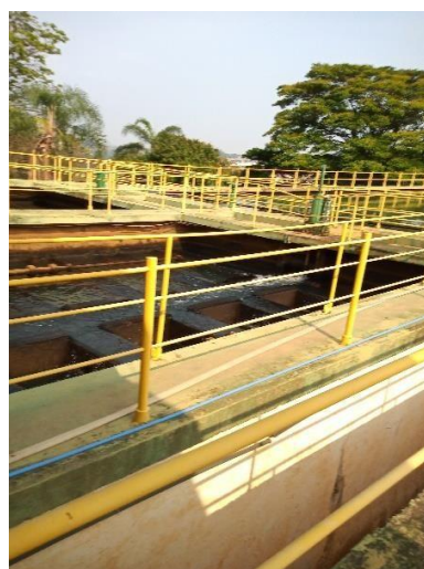
Figura 30 – Referente aos coletores de água decantada
