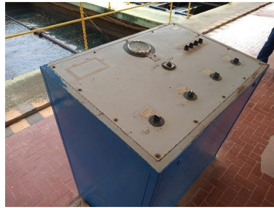
Figuras 33 e 34 - Painel de controle Filtros.
