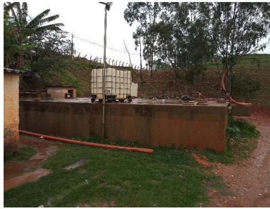
Figura 172 - Armazenamento de chorume para posterior destinação final
