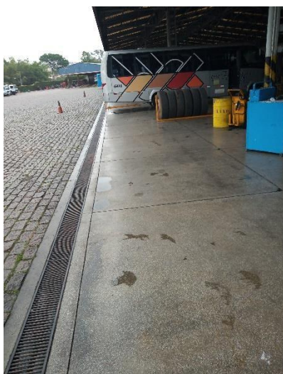
Figura 141 - Coleta de água das áreas de manutenção para destinação a Caixa Separadora de Água e Óleo.
