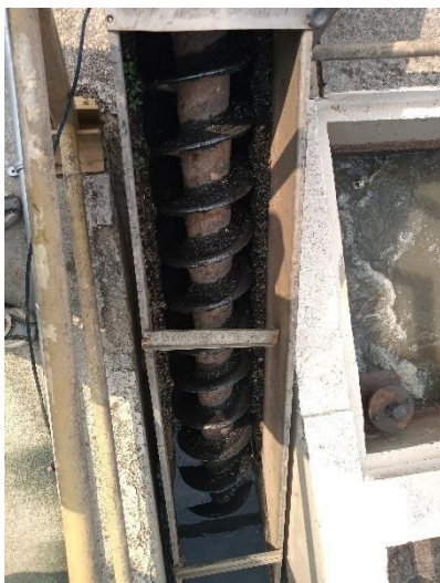
Figura 120 - Rosca de retirada do material da caixa de areia.
