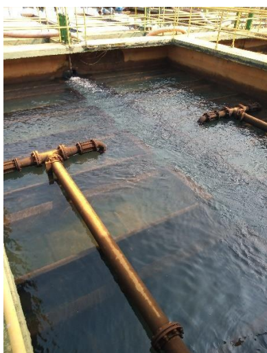
Figura 30 – Referente aos coletores de água decantada
