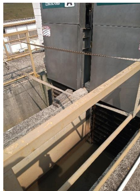
Figura 115 - Gradeamento Mecânico (1 em operação e 1 reserva)
