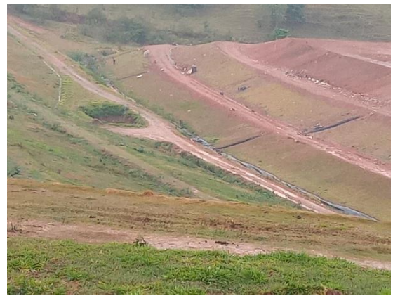
Figura 169 - Sistema de coleta de águas pluviais e chorume.
