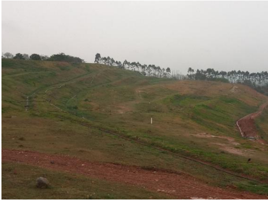
Figura 166 - Vista geral do aterro sanitário encerrado.
