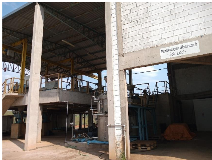
Figura 130 - Desidratação Mecânica do Lodo (Adensador, Centrifuga, Clarificado e adição de polímeros).
