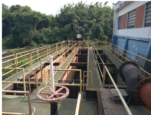
Figura 20 - Captação possui crivo, gradeamento e caixa de areia.
