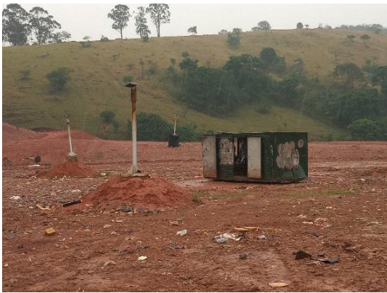
Figura 168 - Queimadores de gás.
