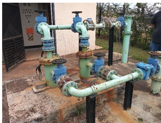
Figura 46 – Elevatória com pelo menos 2 bombas, sendo 1 reserva
