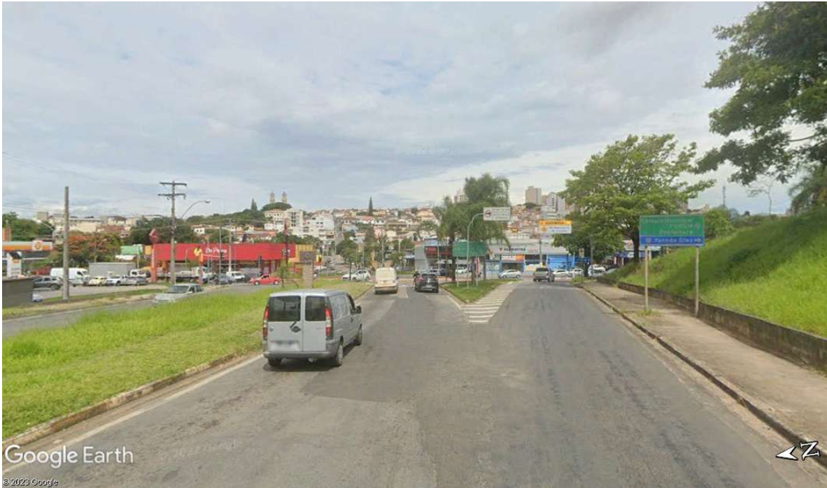
FOTO 5 – Saída da Plínio Salgado para a Av. dos Imigrantes, com sentido norte ou sul e ainda com a opção de sentido centro em frente pela Rua Nicolino Nacaratti. (Fonte: Google Earth).
