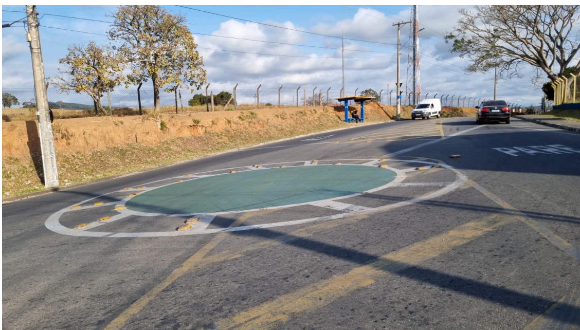
TRECHO DA INTERLIGAÇÃO DA AV LUIZ GONZAGA LEME COM AV ATÍLIO MENIN
