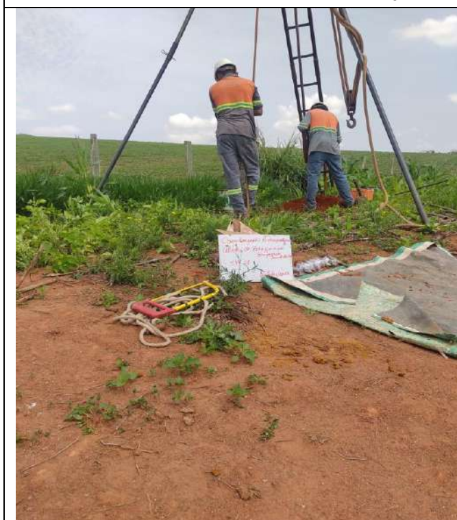
FOTO 04- Visada leste/oeste - SPT-01
