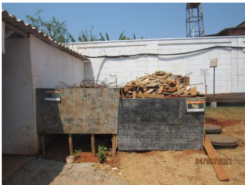
FIGURA 6: Exemplo de baia para metal e madeira.
