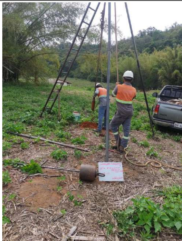
FOTO 06- Visada leste/oeste - SPT -03
