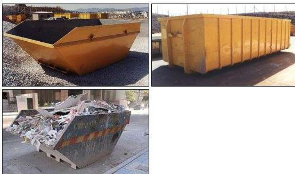
FIGURA 11: Exemplos de caçambas estacionárias e contêineres usados no acondicionamento de resíduos em canteiros de obras.
