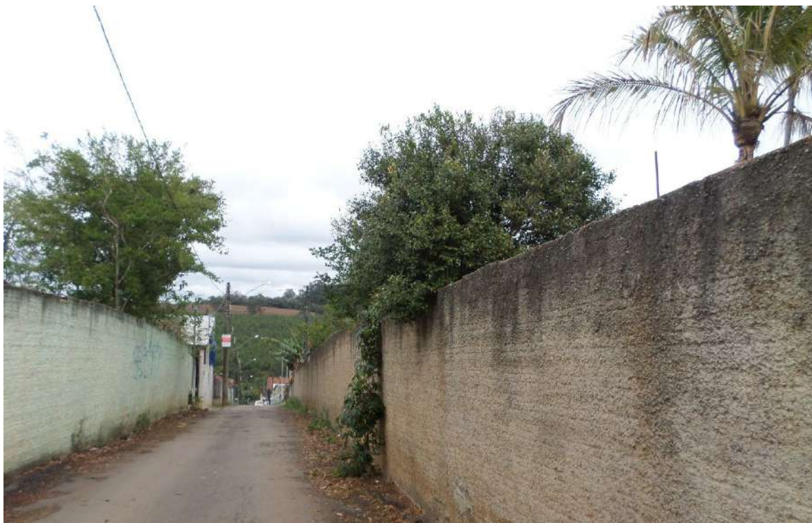
Foto 20. Ausência de Passeios Públicos, Loteamento Paiolzinho.
