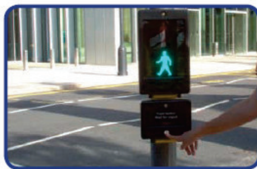
Imagem 52: Semáforo para pedestres com acionamento manual, Manual de Acessibilidade nos municípios do Governo do estado de São Paulo.
