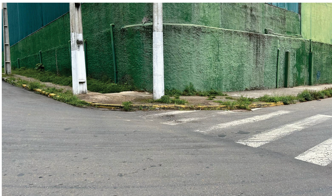
Imagem 47 calçada no cruzamento da Avenida Nossa Senhora da Penha x Rua Ampere. Data: 03/02/2024
