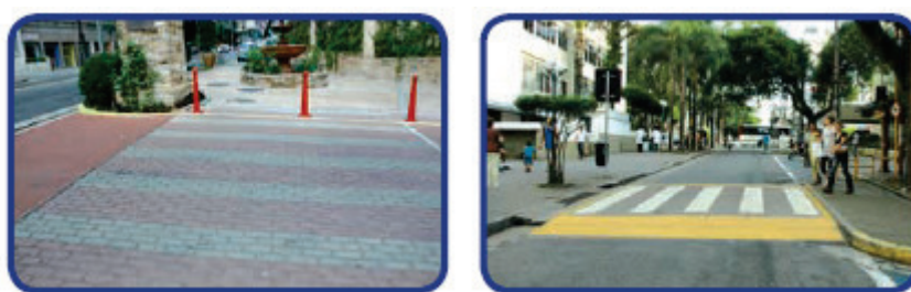
Imagem 48 Faixa elevada na esquina e no meio da quadra, Manual de Acessibilidade nos municípios do Governo do estado de São Paulo.
