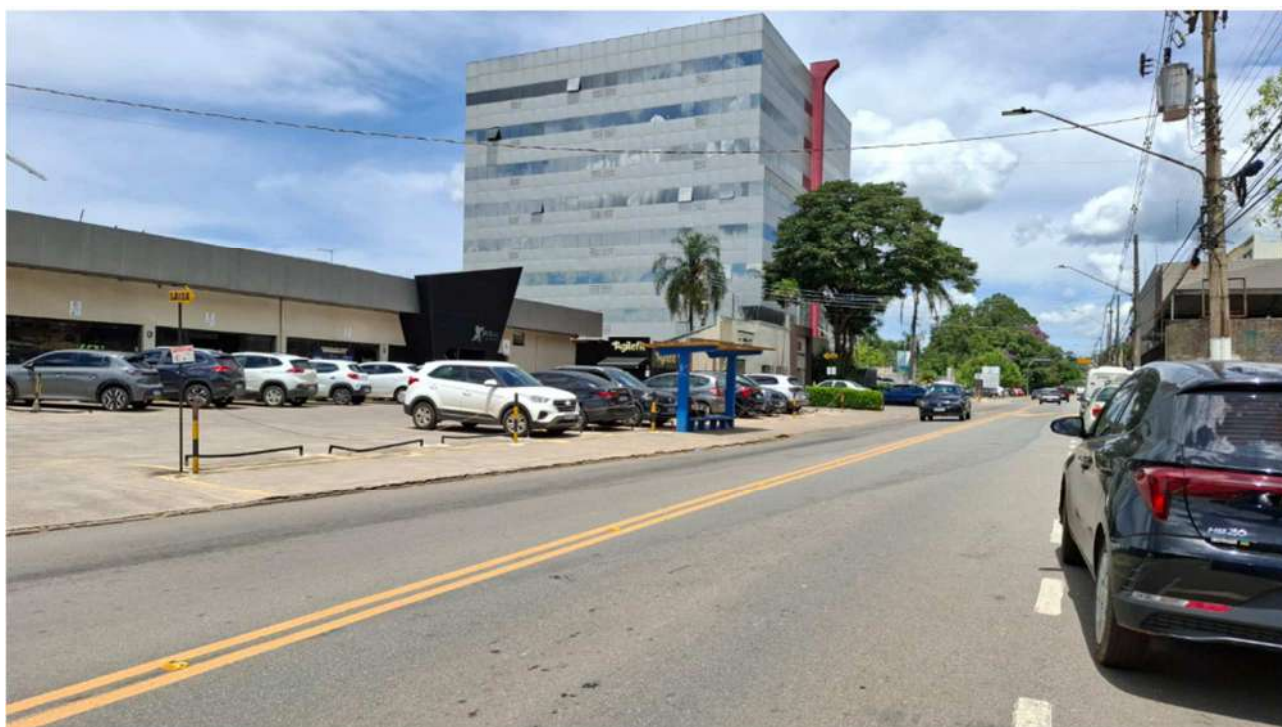
Imagem 13: Início da Av. Salvador Markowicz, área defronte ao empreendimento, Ponto existente que deverá ser substituído conforme Diretriz Urbanística.
