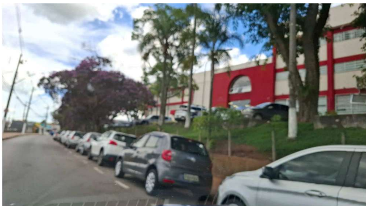
Imagem 20: Prédio do Hospital da USF.
