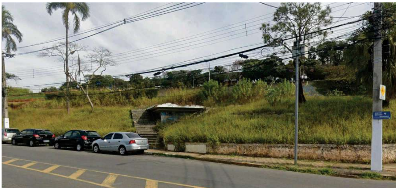
Imagem 28: Fachada da área a ser empreendida.
