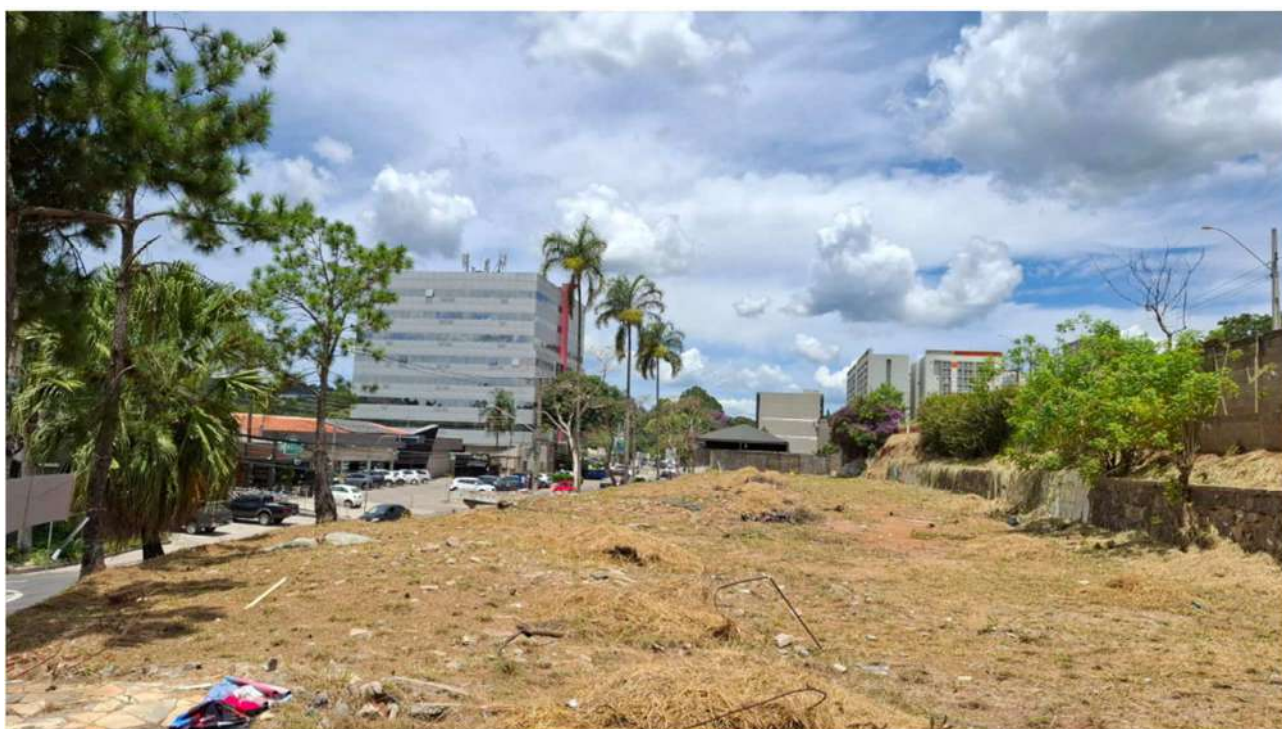
Imagem 10: Antiga construção foi demolida, restando apenas algumas espécies de vegetação não nativa/ exótica.
