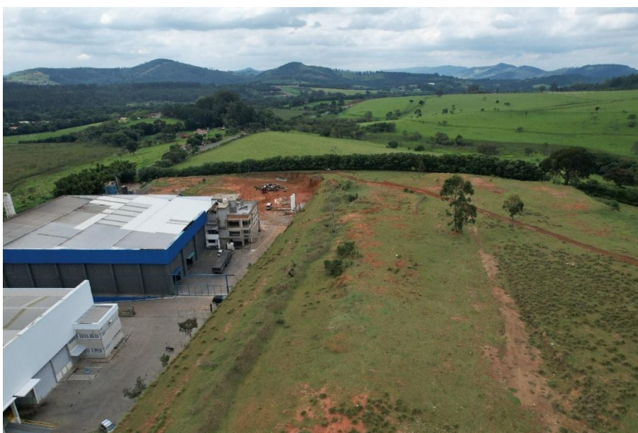
Fotos 01 a 09: Fotos aéreas do imóvel e entorno imediato.
