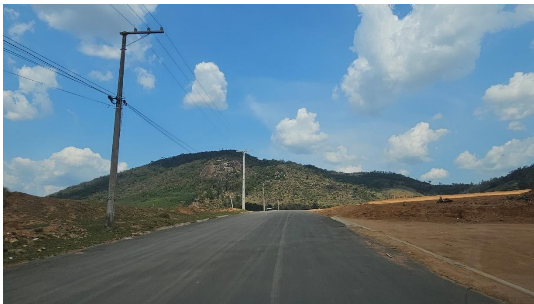
Fotos 23 a 31: Via de acesso ao empreendimento.
