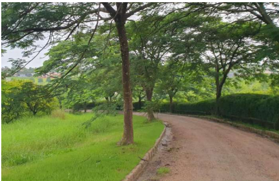
Figura 20: Situação de via no interior do lote do empreendimento. Fonte: Master Ambiental.
