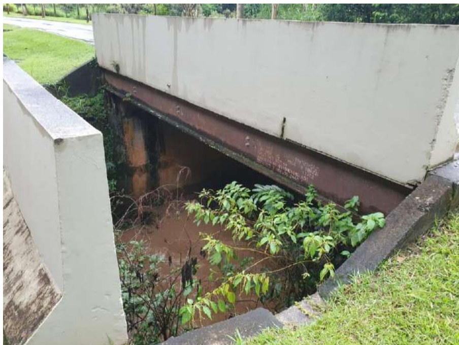
Figura 43: Ponto em que a estrada municipal cruza um curso d'água próximo ao empreendimento. Fonte: Master Ambiental.
