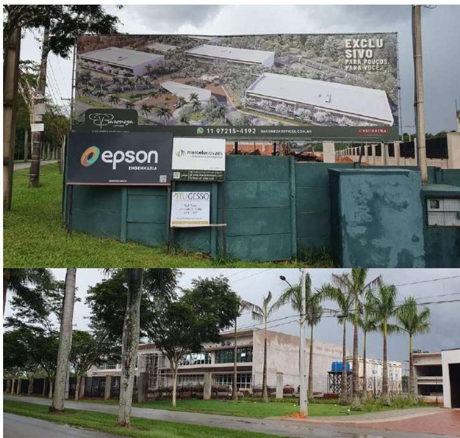
Figura 14: Salas comerciais em construção no início da Estrada Municipal que dá acesso ao empreendimento. Fonte: Master Ambiental.
