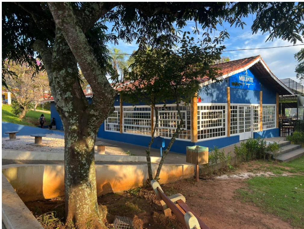
FIGURA 5 – Vista frontal do empreendimento, frente para a Rua Alpeu Grimello.
