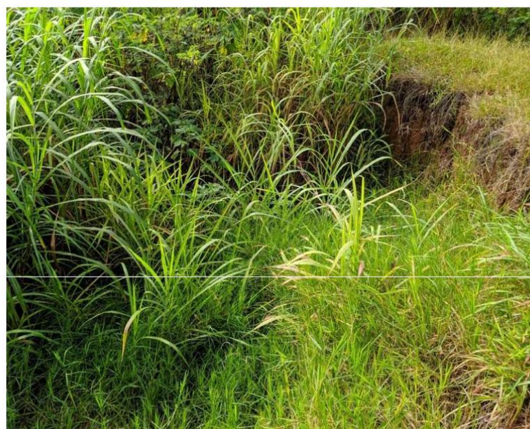
Figura 53 – Local em que se inicia a erosão – Vista II.
