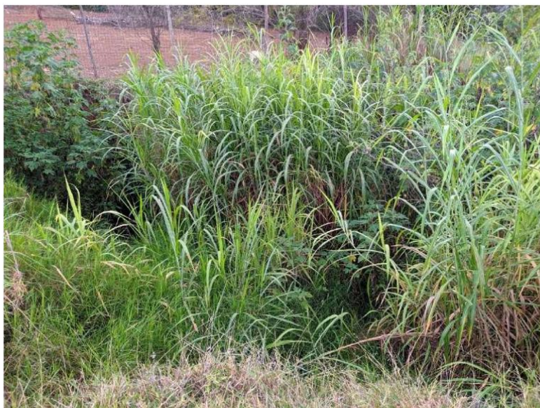
Figura 52 – Local em que se inicia a erosão – Vista I.
