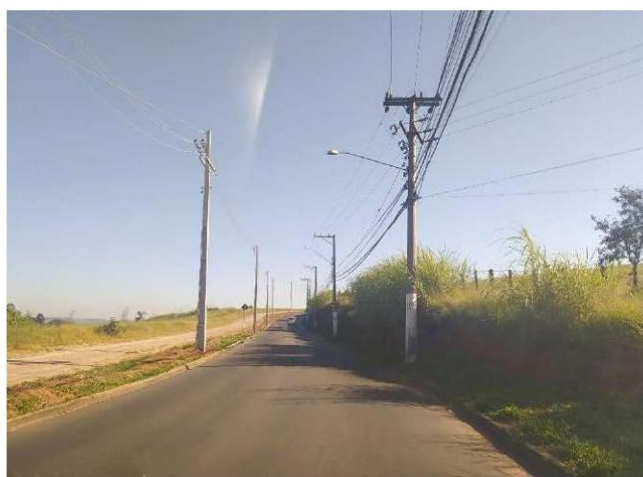
Figura 61 – Rede elétrica na Avenida Atilio Menin.
