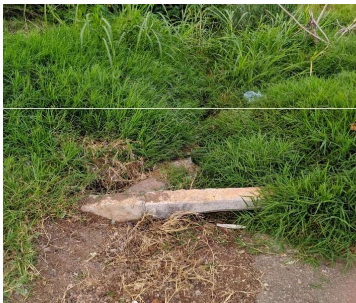
Figura 57 – Estado da saída de água da Rua Benedito Serbino.
