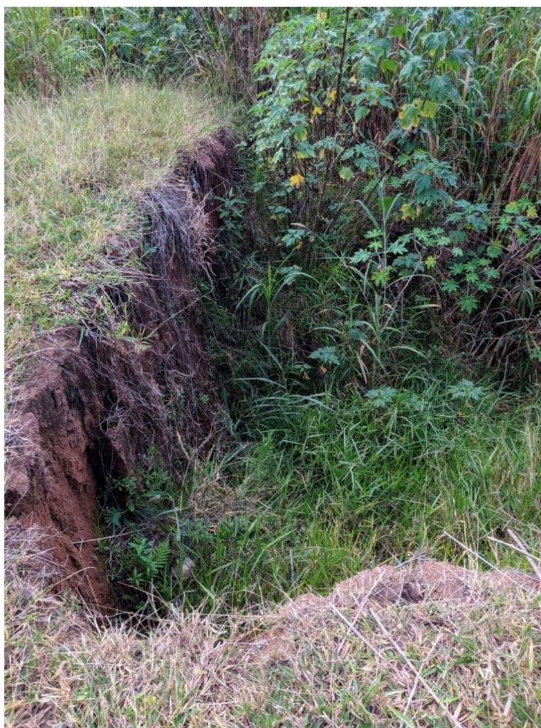
Figura 59 – Local que ocorre erosão.
