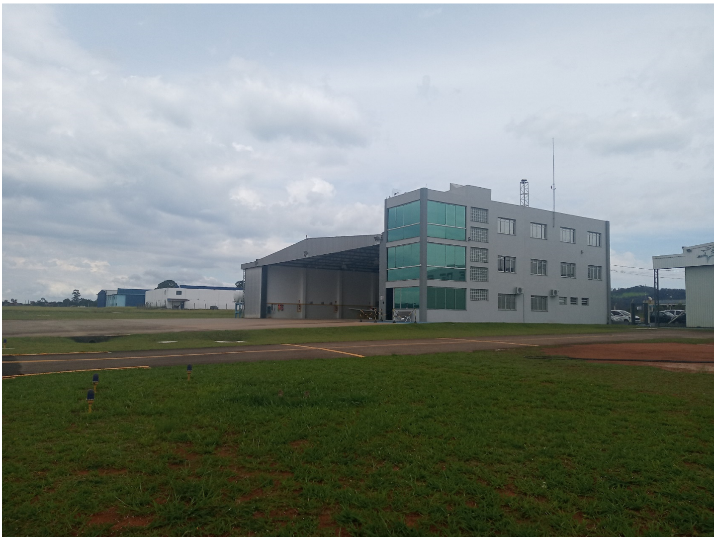
FOTO 04 – Vista geral do entorno do Aero Club, demais atividades no Aeroporto, vista do prédio administrativo e hangar da empresa Fototerra, e demais hangares ocupados por outras empresas ao fundo.
