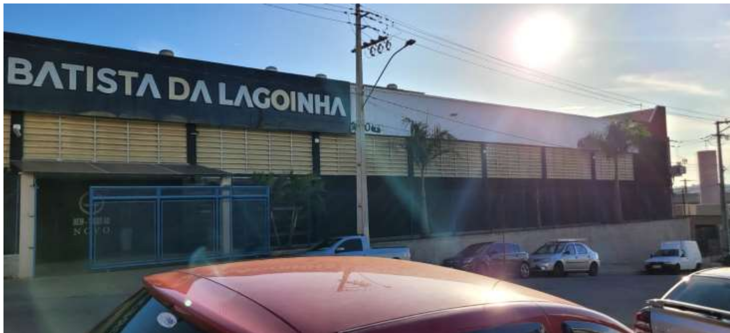
FOTO 01 – Vista geral do lote onde está implantado o prédio , pela Rua da Tecnologia (FONTE: Google Earth).
