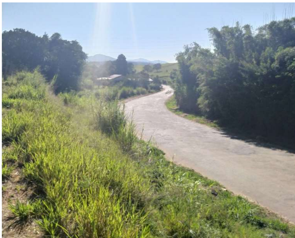
Figura 24 – Avenida Atílio Menin final do empreendimento.
