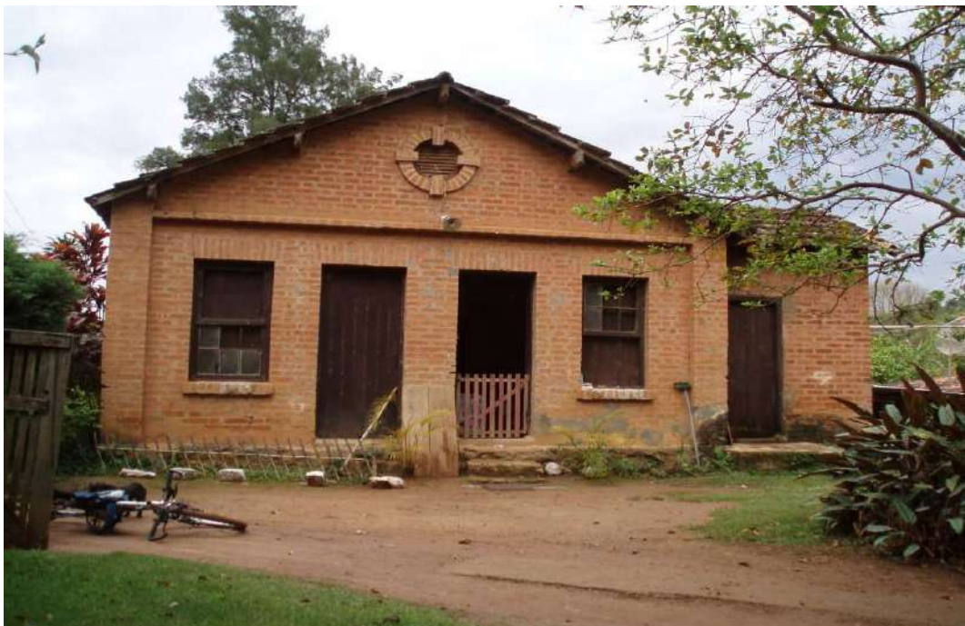
Figura 50 – Casa do Conserveiro.
