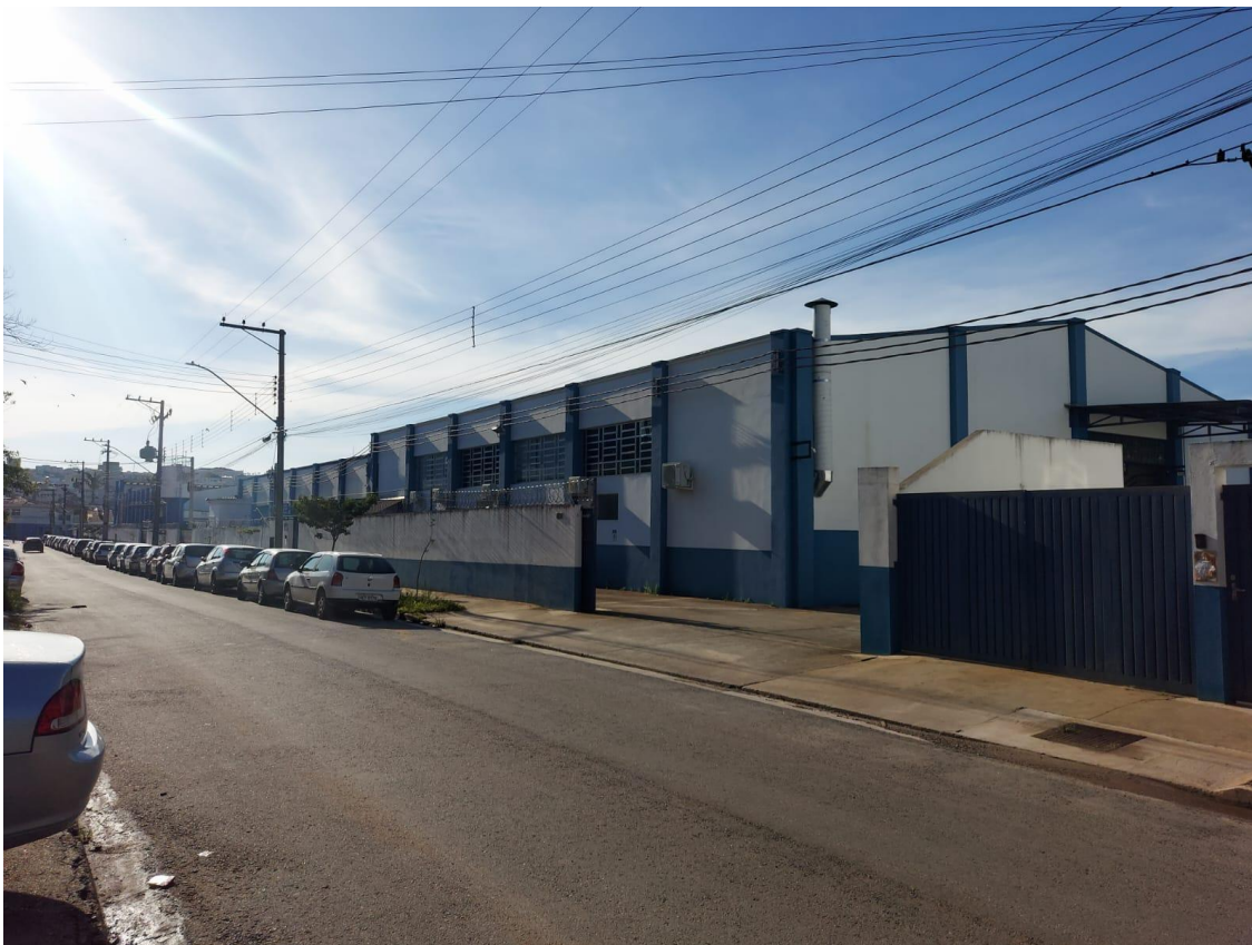
FOTO DO EMPREENDIMENTO – ENTRADA DE CARGA E DESCARGA
