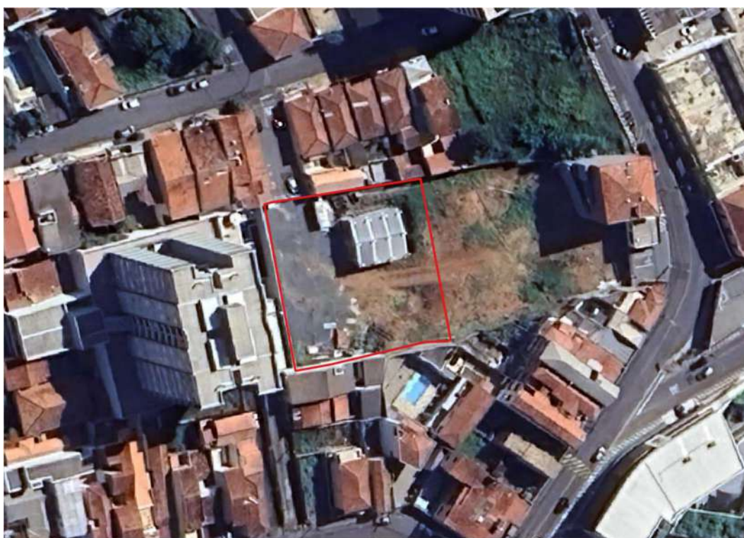
Figura 9: Relevo e Topografia do Terreno. Visão geral da área. Delimitação Vermelha: local do empreendimento sobre a Gleba B. A área do empreendimento está na cota 825, apresentando uma topografia plana, com um amplo platô (ocupando por edificação tipo galpão). Imagem de fundo: Google Earth.
