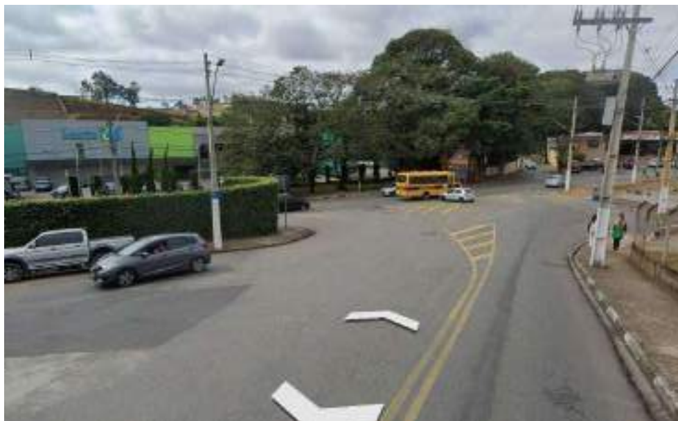
Foto 21 – Área de vizinhança mediata – confluência da Rua Francisco da Silva Leme, Rua Teixeira e Avenida Salvador Markowicz.
