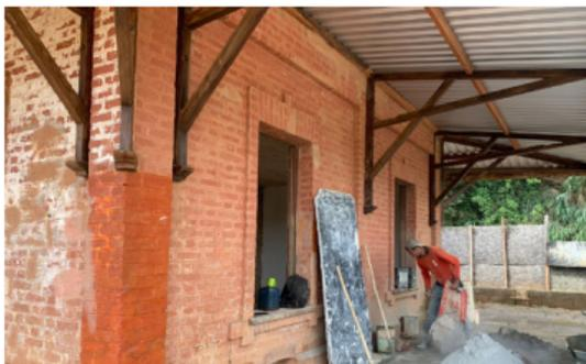
Até o momento, já foi feita a mureta no entorno da estação para instalação de gradil, a fundação do banheiro e instalação do forro de madeira. Está em andamento a alvenaria em bloco de concreto do banheiro, o teste de resina para aplicação nas paredes externas (mantendo o conceito histórico do local) e a instalação de barrote para receber piso de madeira.
