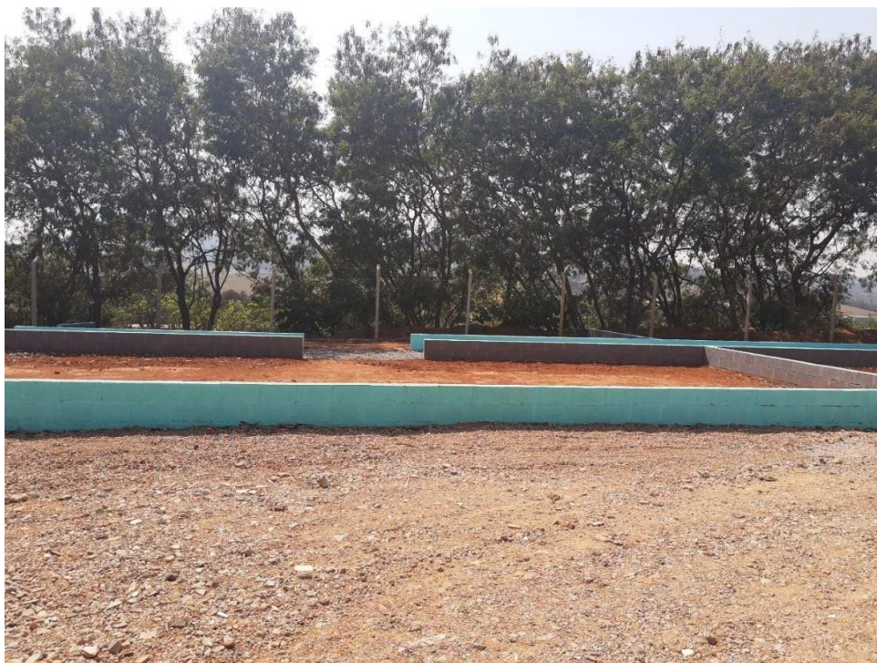
Figura 12: vista das divisórias construídas em área adjacente do viveiro -2020.
