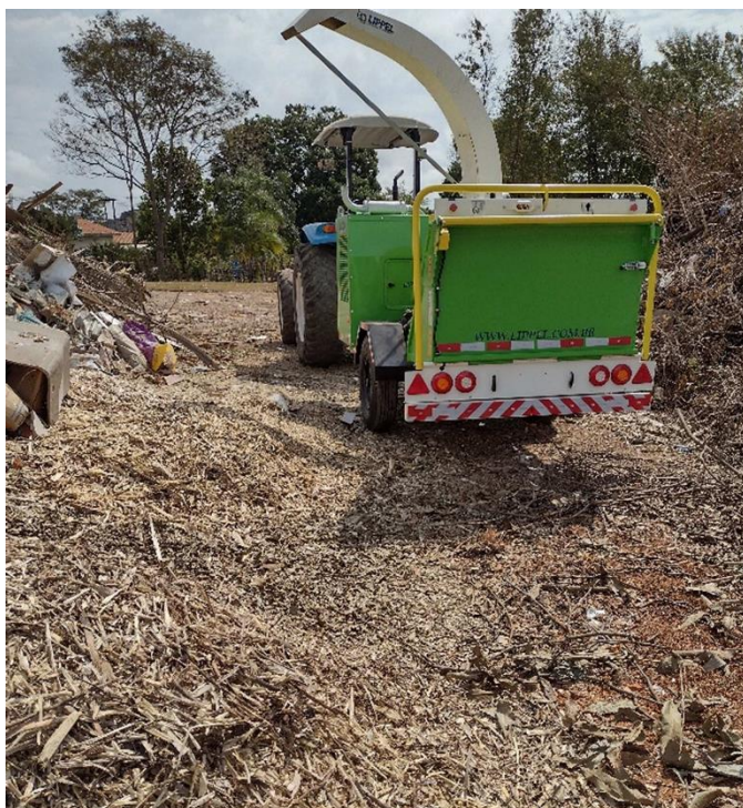
Figura 17: triturador em operação dentro da nova área 2021
