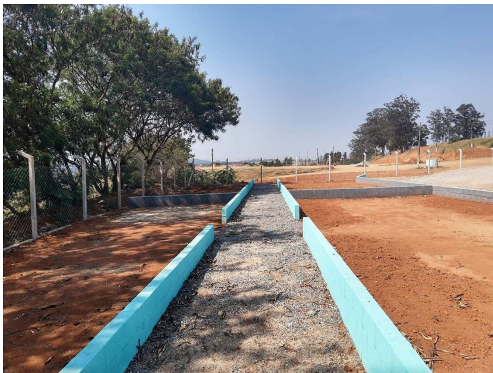
Figura 13: vista das divisórias construídas em área adjacente do viveiro-2020.
