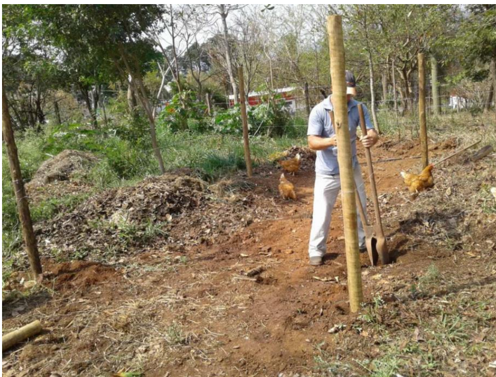
Figura 3: Início da construção da composteira no Viveiro.
