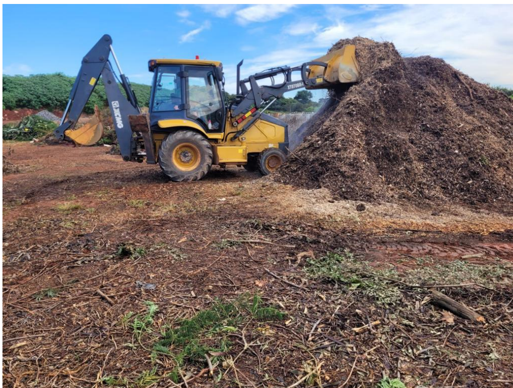
Figura 32: Material (resíduos verdes) sendo empilhado em leiras – 2022.
