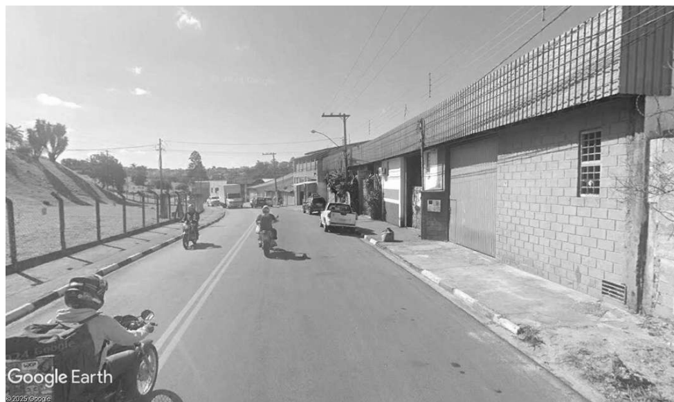
FOTO 11 – Vizinhança mediata composta por galpões comerciais/serviços e industriais (Fonte: Google Earth).
