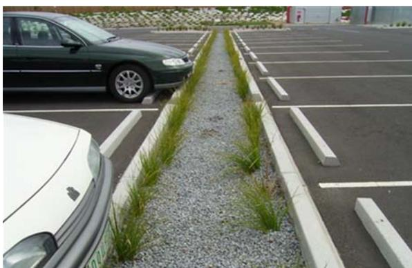
Figura 293. Trincheira de infiltração em estacionamento
