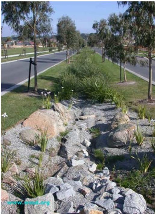
Figura 295. Trincheira de infiltração em canteiro central – WSUD
