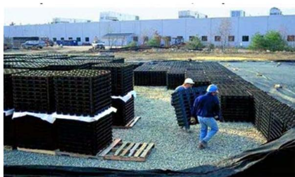
Figura 314.. Reservatório de retenção enterrado
