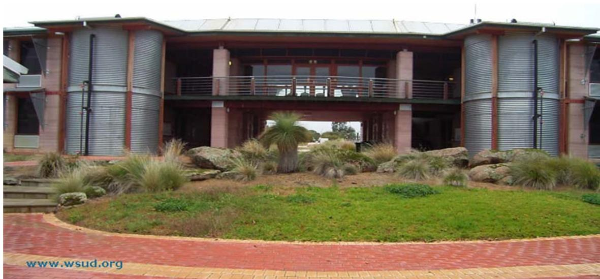
Figura 292. Tanque de chuva incorporado à arquitetura de edifício comercial
