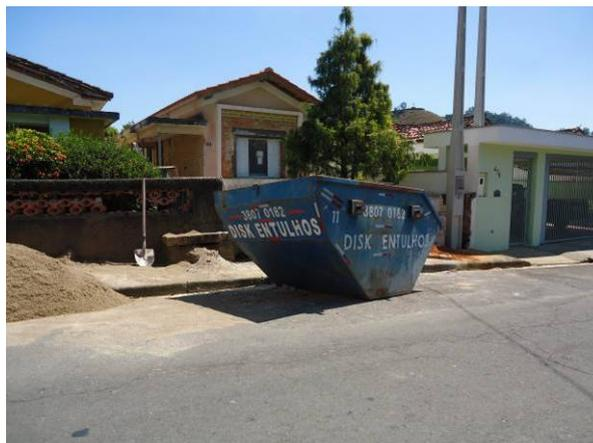
Figura 246. Caçamba de coleta de resíduos da construção civil
