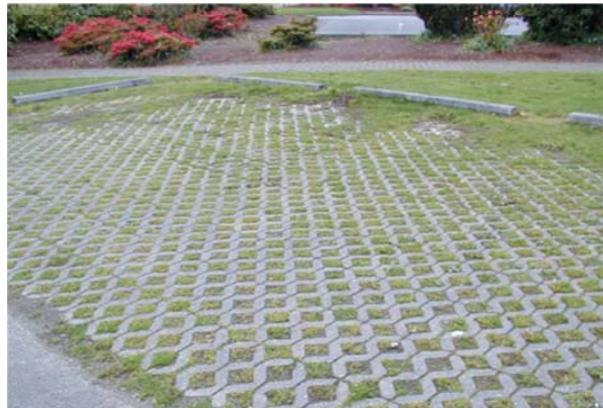
Figura 301. Pavimento permeável em estacionamento
