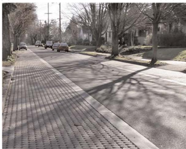
Figura 304. Pavimento permeável em faixas de estacionamento – cidade de Seattle - EUA
