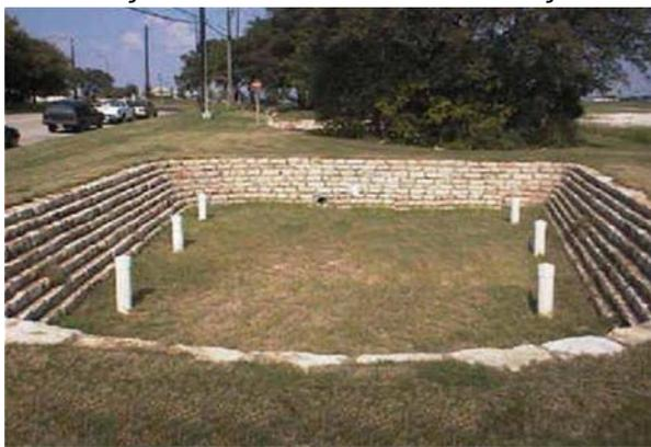
Figura 307. Pequeno reservatório de detenção
