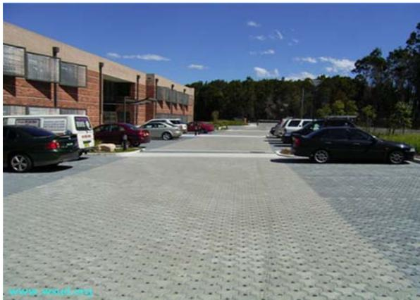
Figura 302. Pavimento permeável – WSUD
