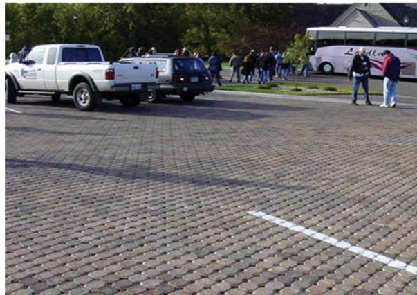
Figura 303. Pavimento permeável em estacionamento
