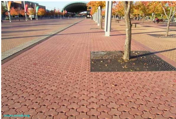
Figura 300. Pavimento permeável – WSUD
