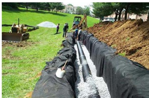
Figura 294. Construção de trincheira de infiltração
