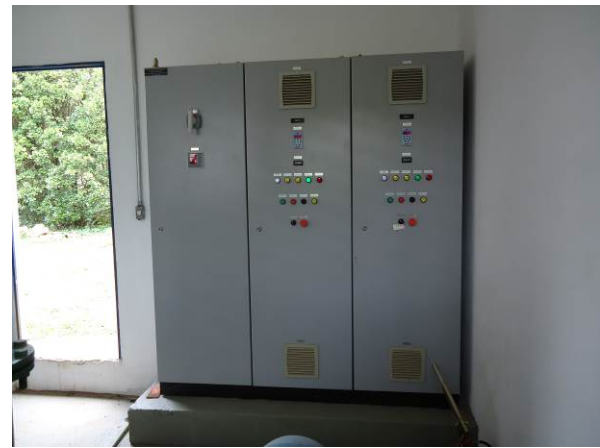
Figura 84. Vista do Painel elétrico dos conjuntos moto-bomba
