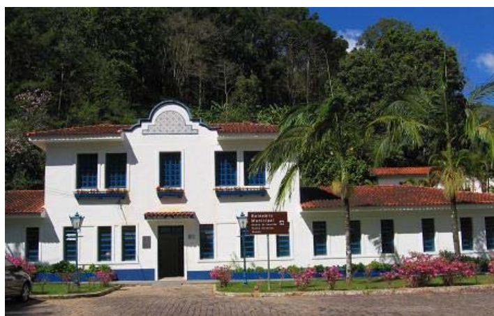
Figura 21. Vista do Balneário Municipal
