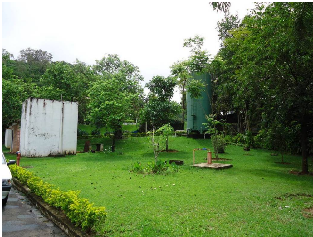
Figura 133. Vista do reservatório de concreto (R-X-B), reservatório metálico (R-X-B) e poço (P4)
