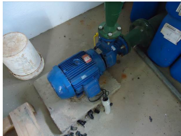
Figura 103. Vista do conjunto motor-bomba reserva
