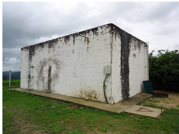
Figura 153. Vista geral do Reservatório R-VIII
