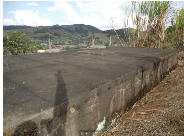
Figura 115. Vista geral do Reservatório Ponte Preta
