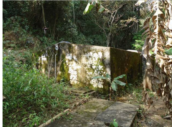
Figura 111. Vista frontal do Reservatório Girardelli
