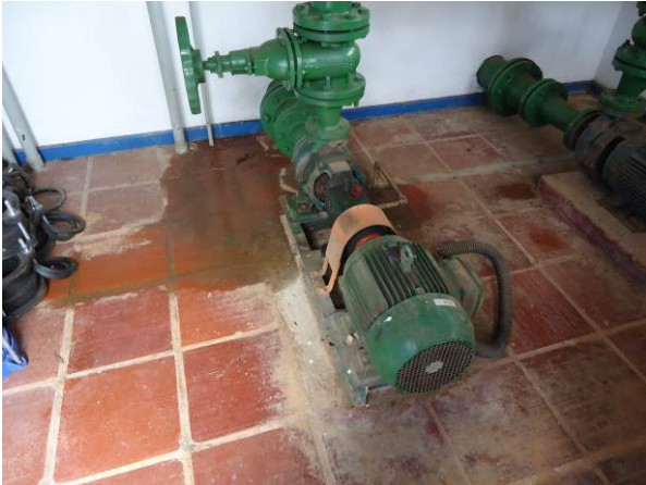
Figura 92. Vista do conjunto moto bomba operante
