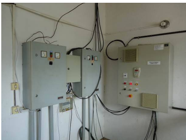
Figura 104. Vista do painel elétrico
