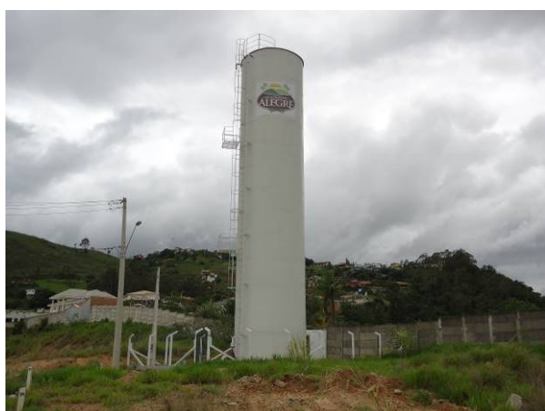
Figura 156. Vista geral do Reservatório R-XI
