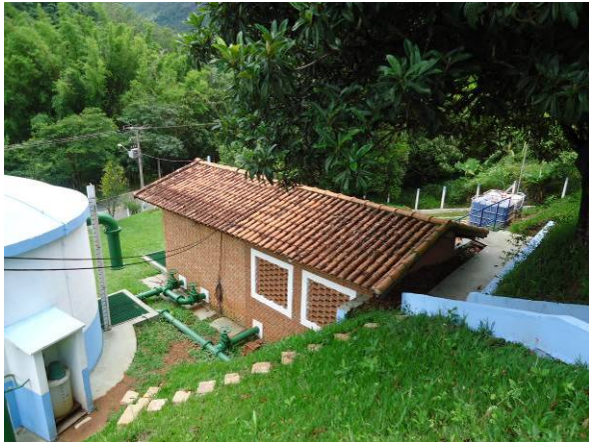
Figura 82. Vista da estação elevatória
