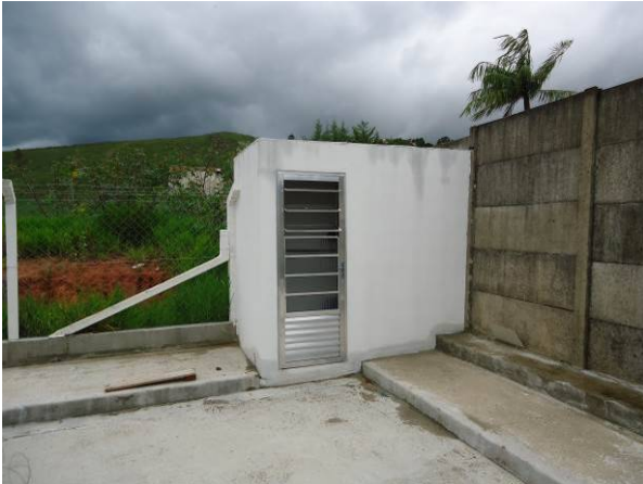
Figura 158. Vista geral do da casa de químicos
