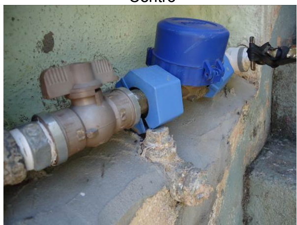
Figura 168. Vista de Hidrômetro com lacre rompido na Rua Joaquim De Oliveira Nº 284 - Centro
