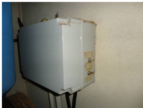
Figura 122. Vista do painel elétrico do booster do Parque dos Ipês.
