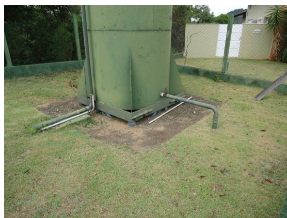
Figura 119. Tubulações de saída e de entrada do reservatório
