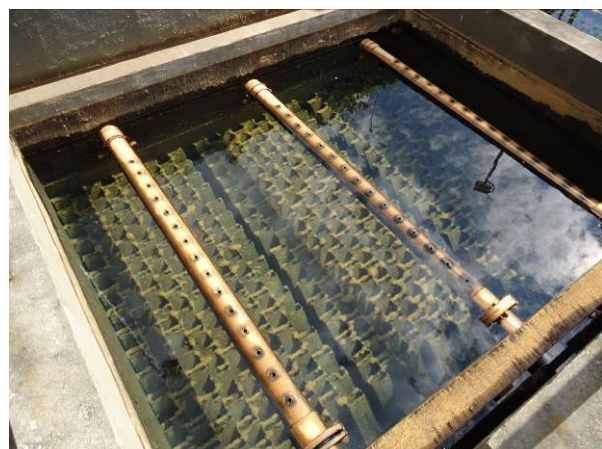
Figura 69. Perfil de decantação da linha2
