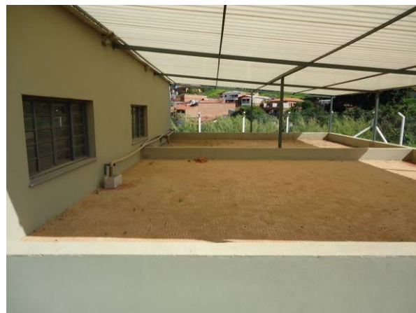
Figura 183. Local de secagem do lodo gerado na ETE do loteamento Terras de Monte Alegre
