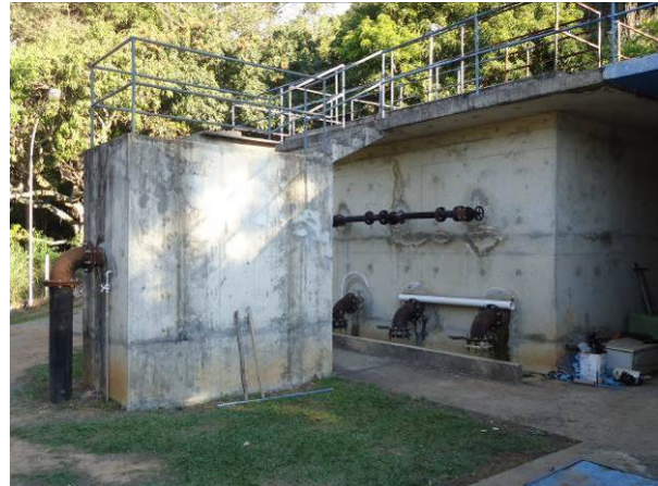
Figura 74. Câmaras de controle de nível da linha 2
