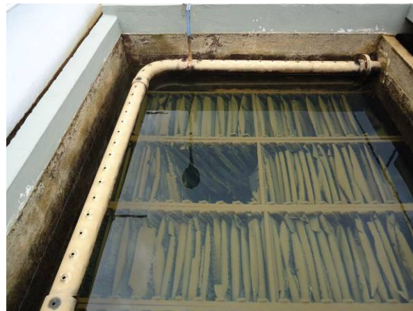
Figura 71. Vista dos perfis de decantação da Linha1
