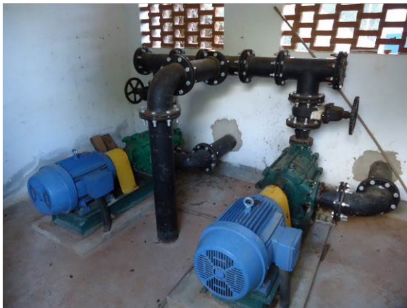
Figura 83. Elevatória com dois (02) conjuntos moto-bomba
