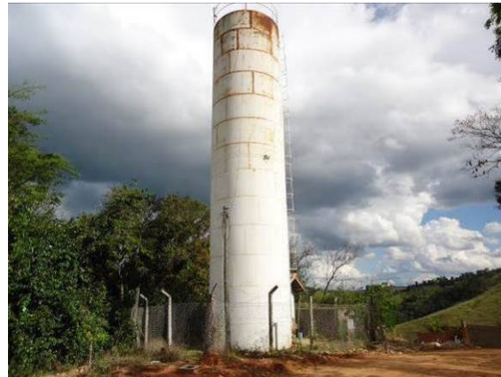
Figura 113. Vista lateral do Reservatório Ponte Preta
