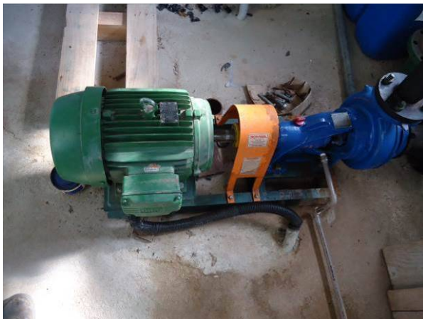
Figura 102. Vista detalhada do conjunto motor-bomba
