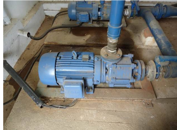
Figura 141. Vista detalhada do conjunto motor-bomba operante
