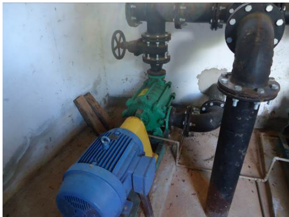
Figura 85. Vista do conjunto moto-bomba 1
