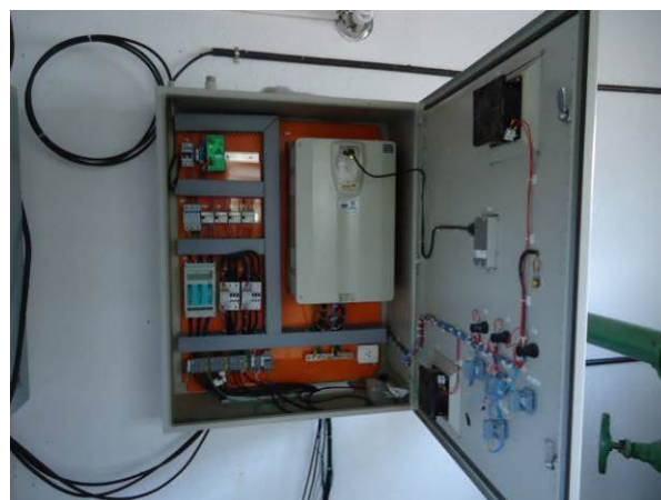
Figura 105. Vista do painel elétrico aberto
