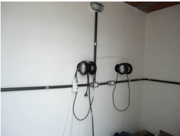
Figura 160. Vista das bombas dosadoras de químicos
