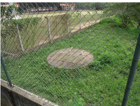
Figura 185. Vista da Estação Elevatória de Esgoto – EEE – 4
