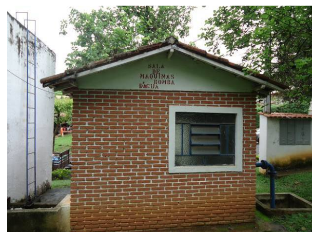
Figura 139. Vista geral da casa de bombas
