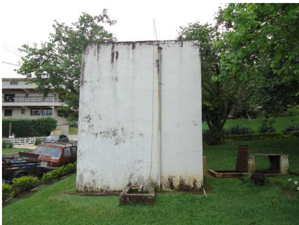
Figura 136. Vista geral do Reservatório R-X-A
