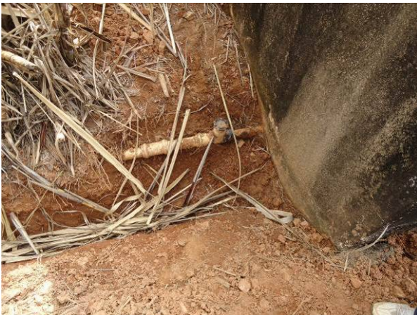
Figura 116. Saída do reservatório
