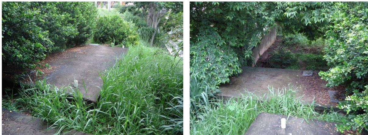
Figura 180. Vista da fossa filtro existente no Parque dos Ipês
