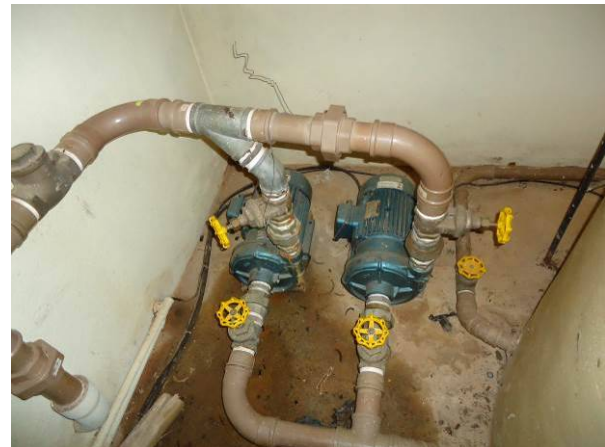
Figura 121. Vista dos conjuntos motobomba do “booster”
