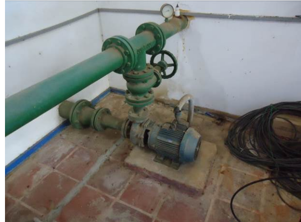
Figura 93. Vista do conjunto moto bomba reserva
