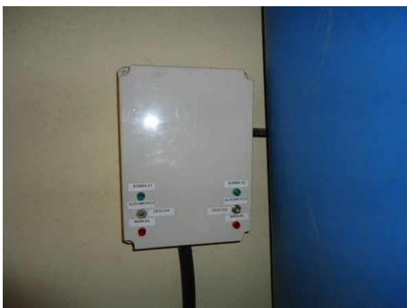
Figura 178. Painel elétrico da Estação Elevatória de Esgoto (EEE) existente no Parque dos Ipês
