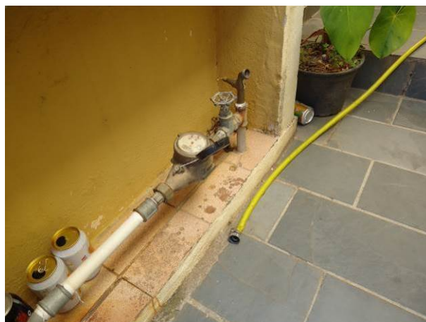
Figura 166. Vista do Hidrômetro sem lacre na Rua Joaquim De Oliveira Nº 60 - Centro
