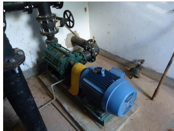
Figura 86. Vista do conjunto moto-bomba
