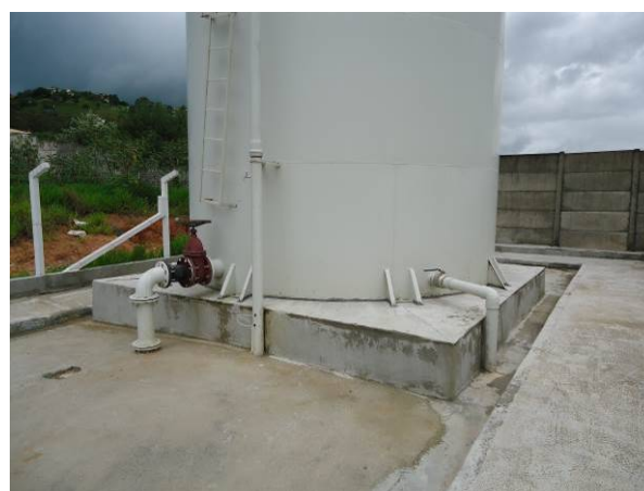
Figura 157. Vista das tubulações de saída do Reservatório
