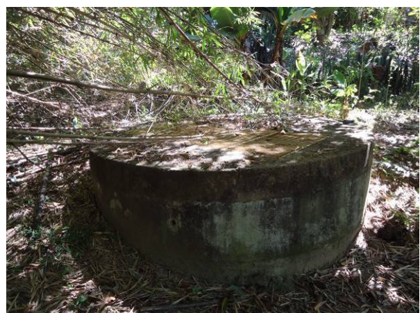
Figura 186. Vista da Estação Elevatória de Esgoto – EEE – 5
