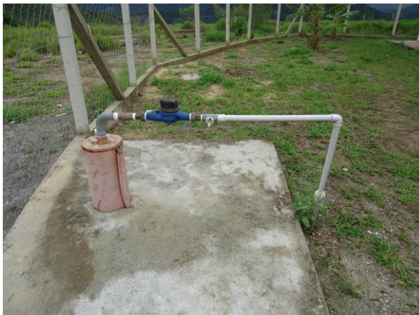
Figura 152. Vista geral do poço
