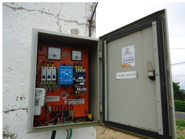
Figura 155. Vista do painel elétrico de Comando de Bomba aberto
