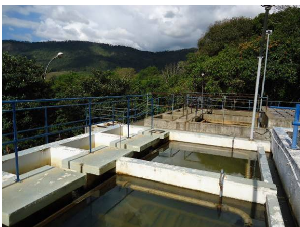
Figura 68. Vista geral dos decantadores
