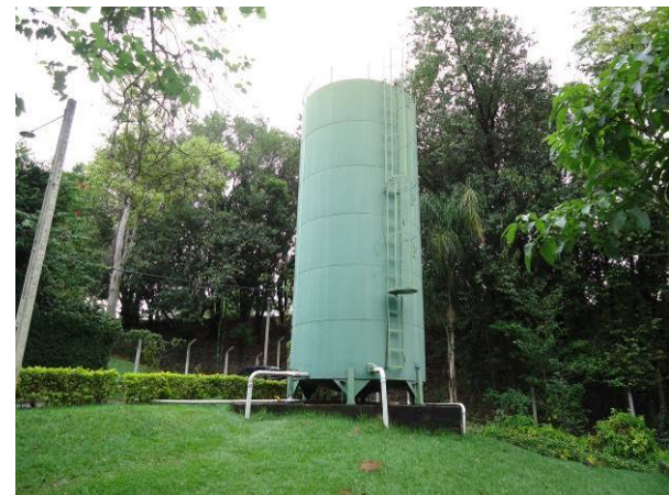
Figura 137. Vista geral do Reservatório R-X-B
