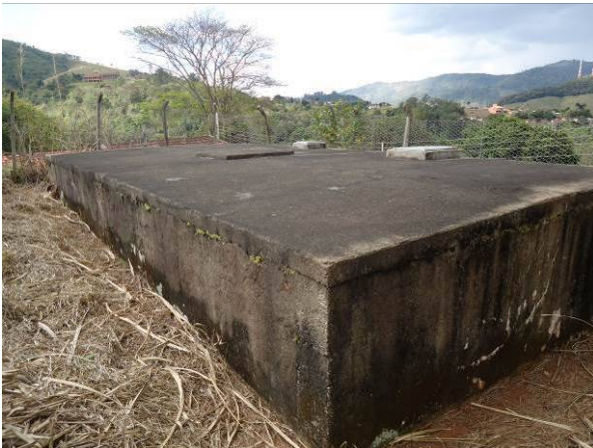
Figura 114. Vista geral do Reservatório Ponte Preta
