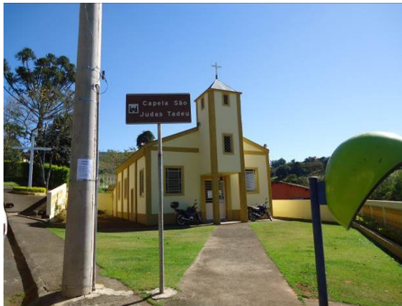
Figura 11. Vista da Igreja São Judas Tadeu
