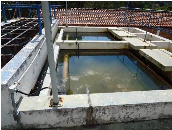
Figura 66. Vista do decantador da Linha1
