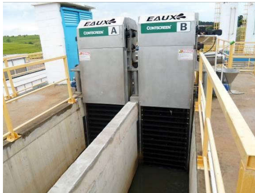
Figura 74 – Gradeamento mecanizado com compactador.
