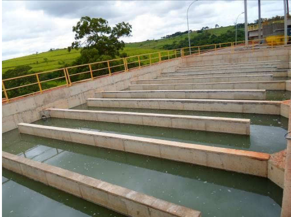
Figura 84 - Tanque de contato e caixa de saída do efluente tratado, com sensor de nível ultrassônico.
