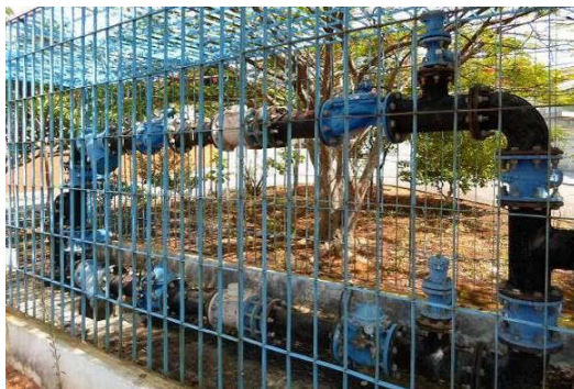
Figura 52 - Conjunto de VRP's instaladas na rede de distribuição do SAA.
