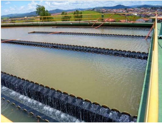
Figura 31 – Decantadores convencionais da ETA.
