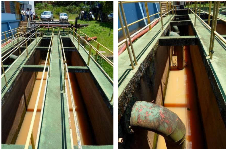
Figura 20 – Vistas do canal de sucção para a EEAB.
