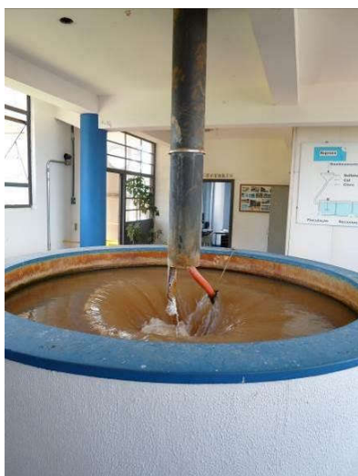
Figura 33 - Chegada de água “tulipa” com dosagens de Sulfato de Alumínio, hidróxido de cálcio e cloro.
