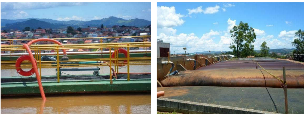
Figura 36 – Sistema de Sucção do Lodo dos Decantadores e Bags para desague do lodo.
