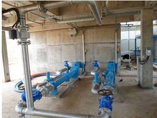
Figura 80 – Conjunto de bombas de envio do lodo para os Adensadores.
