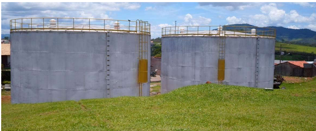
Figura 47 - Reservatórios de 1000 m 3 cada existentes na área da ETA.
