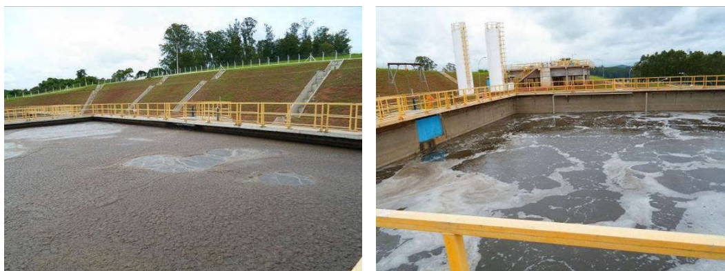
Figura 75 – Tanques de Aeração.
