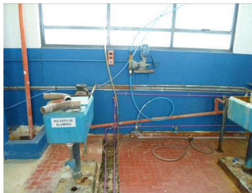
Figura 34 – Unidades de dosagem de Cal e de Sulfato de Alumínio.
