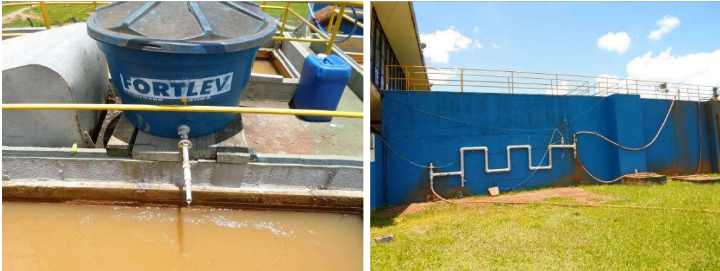
Figura 35 – Tanque de adição de Copolímero aquoso e Tubulação de Copolímero para a Desidratação do Lodo.
