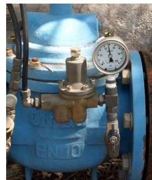
Figura 52 - Conjunto de VRP's instaladas na rede de distribuição do SAA.
