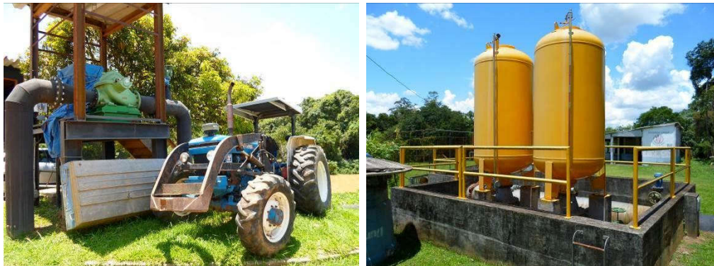
Figura 24 – Vistas do conjunto moto-bomba reserva (utilizado somente em casos de enchente) e dos tanques de acumulação hidráulica anti-golpes de aríete.
