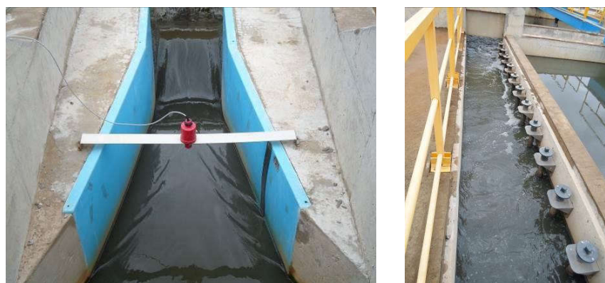
Figura 72 – Calha Parshall de entrada com sensor de nível e redutores de velocidade - Serpentina.
