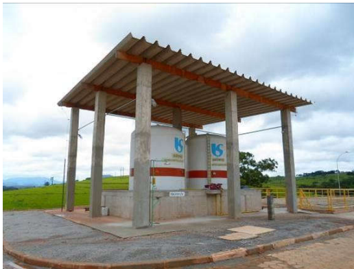
Figura 83 – Reservatório de Hipoclorito.
