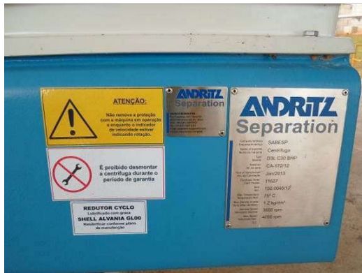
Figura 79 – Centrífuga para desidratação do lodo da ETE.
