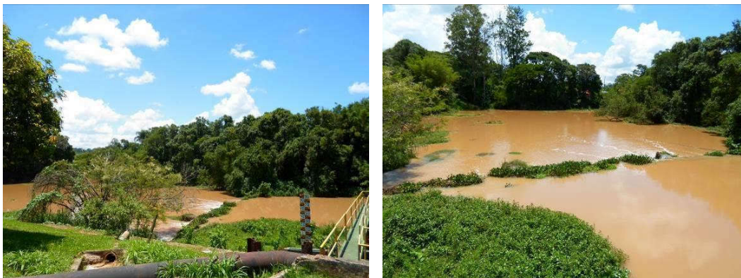
Figura 18 – Vistas da barragem de elevação de nível para a tomada d'água.
