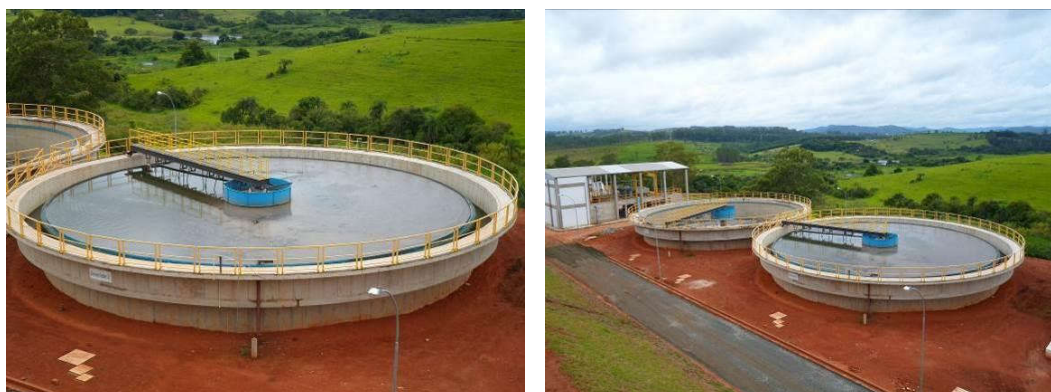
Figura 76 – Decantadores Secundários.
