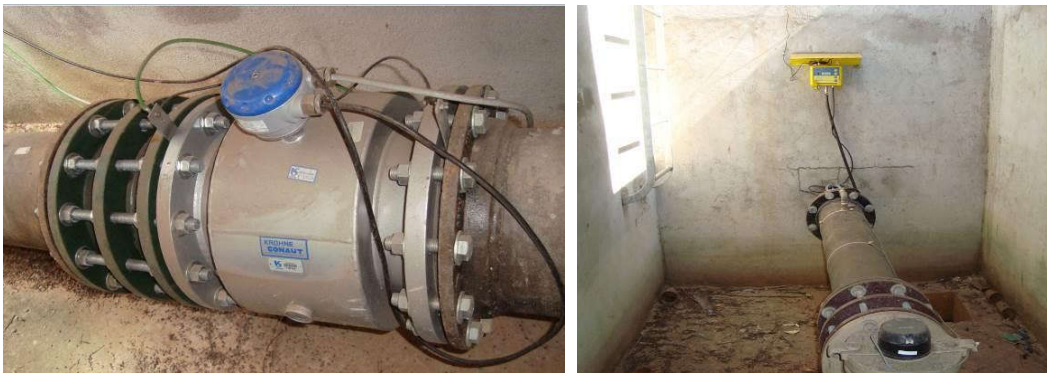
Figura 54 – Macromedidor eletromagnético e dispositivo de telemetria instalados na rede de distribuição.
