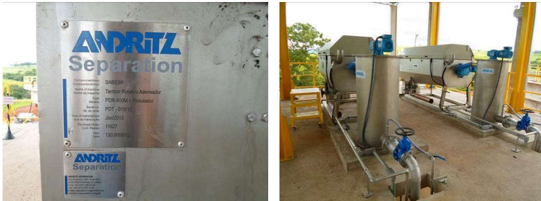
Figura 78 – Adensadores mecanizados para o lodo.
