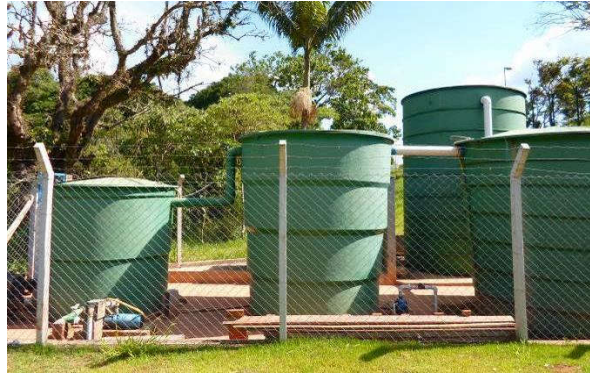
Figura 85 – Tratamento biológico de esgoto – Condomínio Portal de Bragança.
