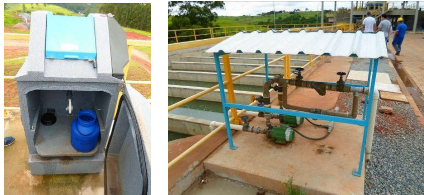
Figura 81 – Analisador e seu conjunto de bombas.
