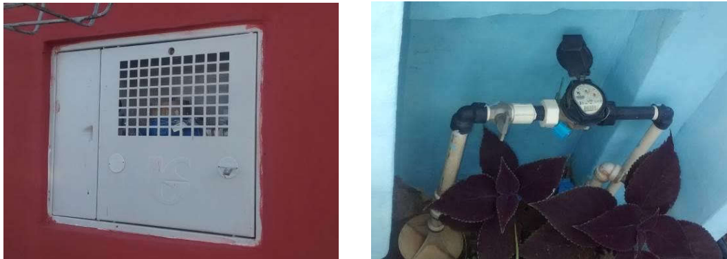
Figura 55 – Cavalete e caixa padrão SABESP para os hidrômetros.
