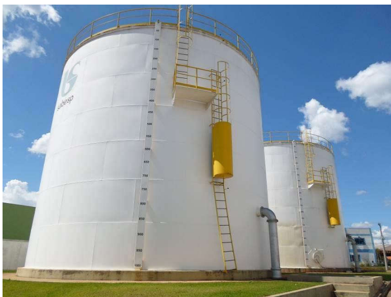
Figura 48 - Reservatórios Sevilla - 1000 m 3 cada.
