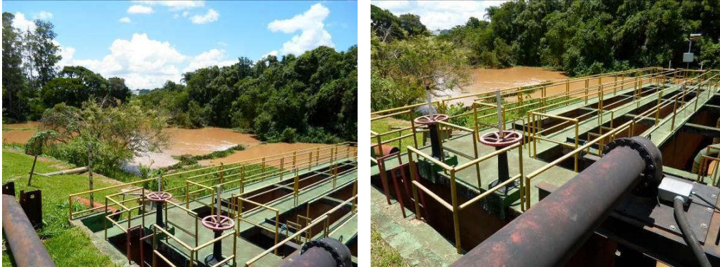
Figura 19 – Vistas das estruturas da tomada d'água.
