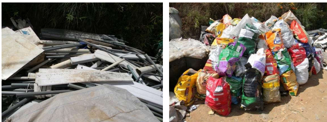
Figura 108 – Tubos de PVC e sacos contendo vidro.
