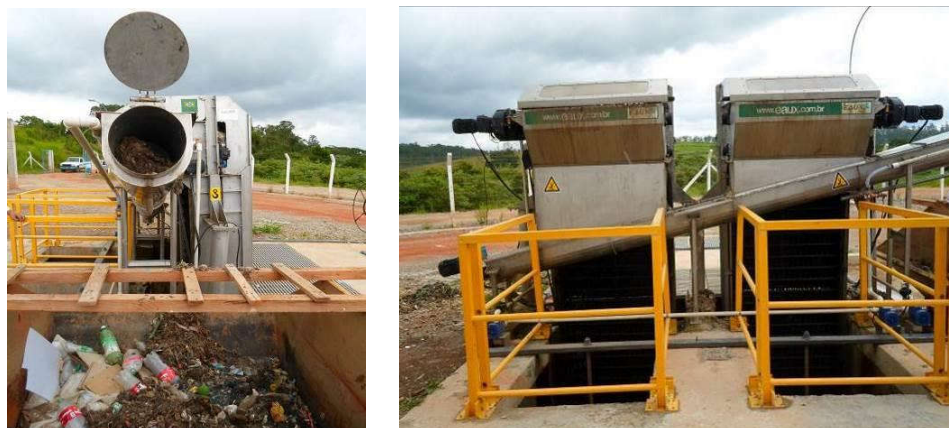
Figura 70 – Gradeamento mecanizado com compactador, gradeamento grosseiro.
