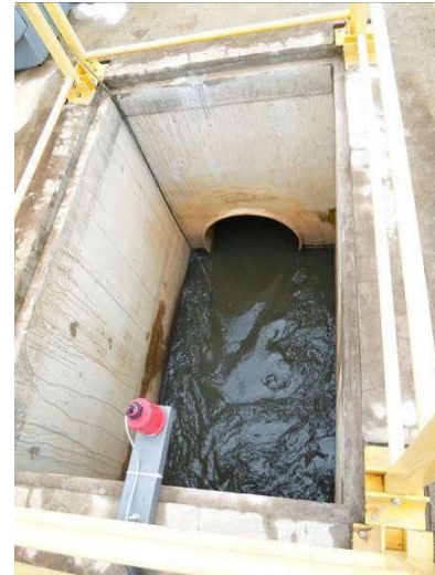
Figura 84 - Tanque de contato e caixa de saída do efluente tratado, com sensor de nível ultrassônico.
