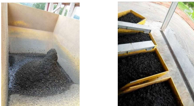
Figura 71 – Areia retida nas caixas e Lodo após o processo de secagem.
