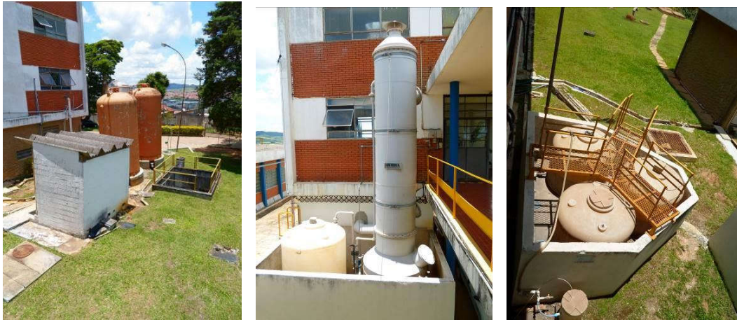
Figura 37 – Tanques de armazenamento de Sulfato de Alumínio, Soda (equipamento lavador/neutralizador de cloro) e ácido fluossilícico.
