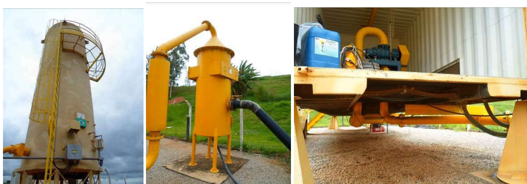
Figura 120 – Sistema de Captação e Queima do Biogás.
