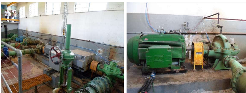
Figura 22 – Disposição geral das bombas centrífugas do sistema elevatório.
