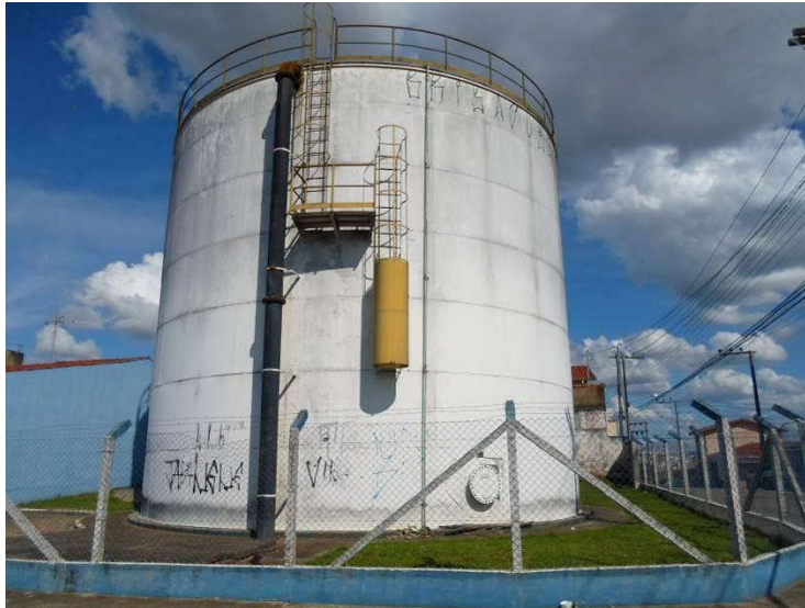
Figura 49 - Reservatório Vila Mota 1000 m 3 .
