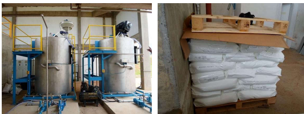
Figura 77 – Preparadores de polímero para adensamento e desidratação do lodo.
