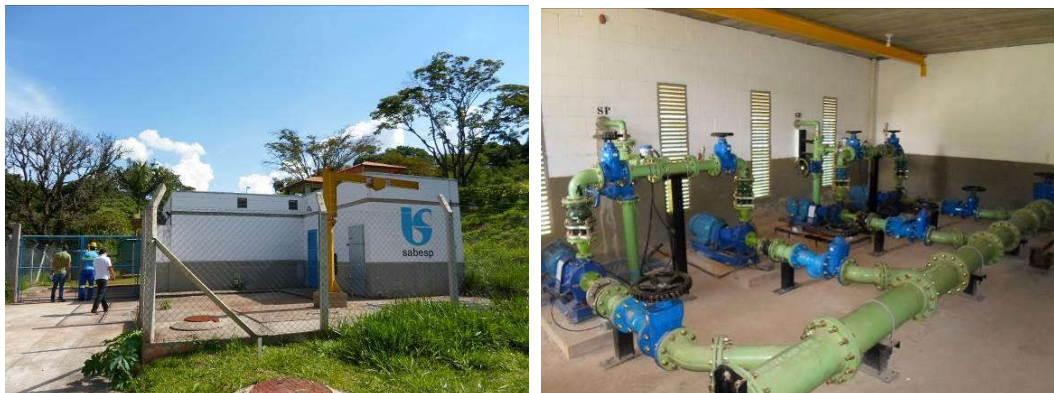
Figura 43 - EEAT Portal de Bragança.
