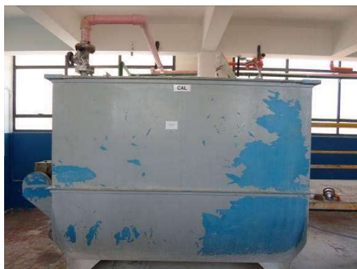
Figura 34 – Unidades de dosagem de Cal e de Sulfato de Alumínio.
