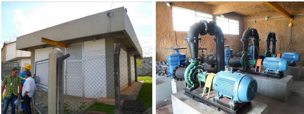
Figura 42 – Vista da casa de bombas e das bombas do Booster Eusébio Savaio.
