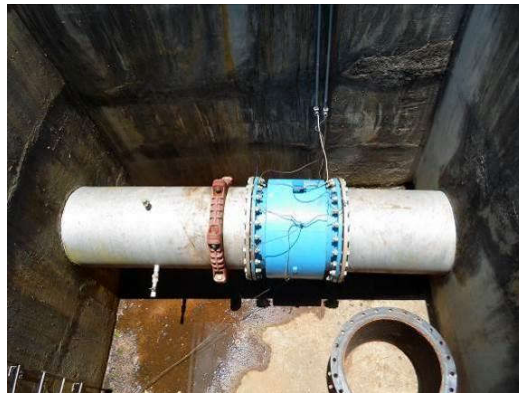
Figura 38 - Macromedidor de Entrada e conversor de unidades.
