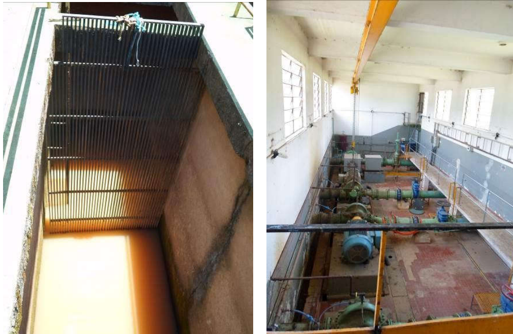
Figura 21 – Vistas do sistema de gradeamento para o canal de sucção para a EEAB, e da disposição geral das bombas centrífugas do sistema elevatório.
