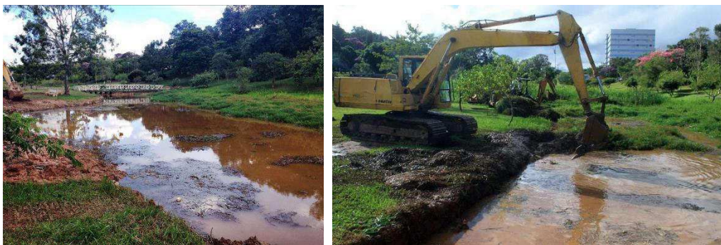
Figura 142 – Vistas 3 e 4 do Lago do Taboão assoreado e durante as medidas de desassoreamento.
