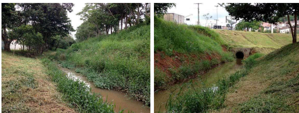
Figura 177 - Ponto de alagamento no Ribeirão Califórnia.
