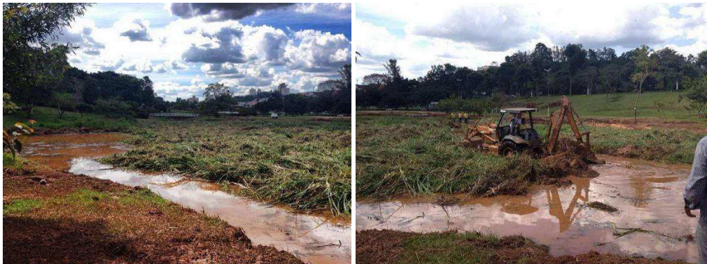
Figura 141 – Vistas 1 e 2 do Lago do Taboão assoreado e durante as medidas de desassoreamento.
