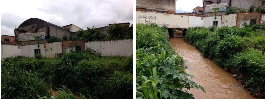
Figura 174 - Local onde ocorreu um desmoronamento de um restaurante devido a cheia no Ribeirão Lavapés.
