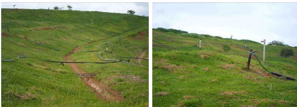
Figura 126 – Sistema de Captação do Biogás.
