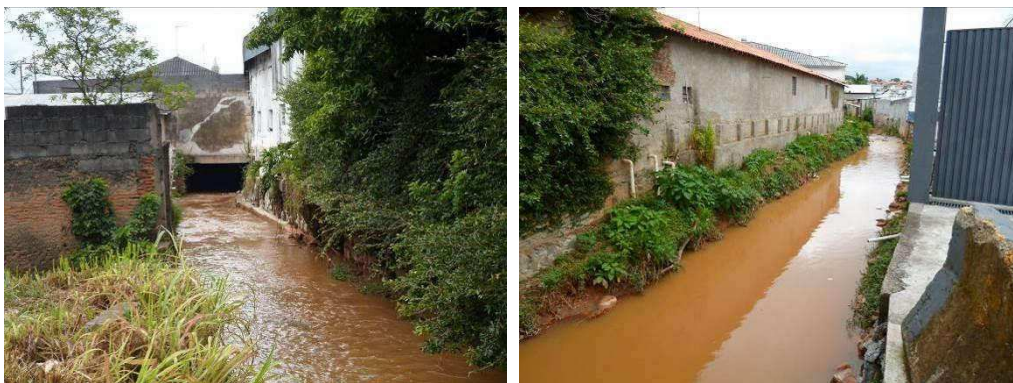
Figura 175 - Ponto de Alagamento do Ribeirão Lavapés na Av. dos Imigrantes.
