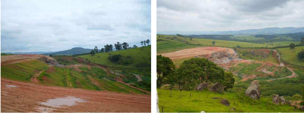
Figura 127 - Vista do aterro que está inoperante devido ao escorregamento de seus taludes.
