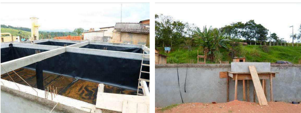
Figura 129 – Construção do tanque para tratamento do choro.
