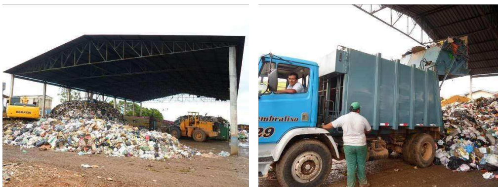
Figura 122 – Área de transbordo localizada no mesmo galpão da triagem de materiais recicláveis. Ao lado um caminhão coletor-compactador descarregando os resíduos da coleta de RPU que serão acondicionados em carretas para serem encaminhados ao aterro de Paulínia.
