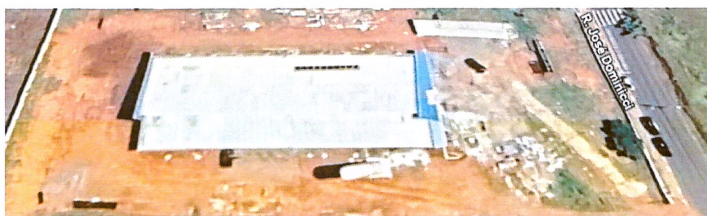
Terreno cercado, início das obras e fase adiantada de construção. (imagens de 2024 e março de 2025)
