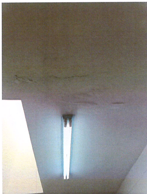
Infiltração no teto do corredor direito.
