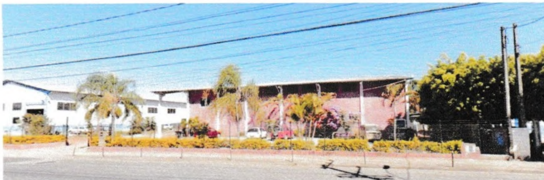
Imagem 7: Acesso de veículos, pedestres e portaria
