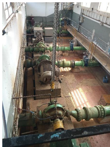
Figura 22 - Casa de Bombas com 4 conjuntos de bombas.
