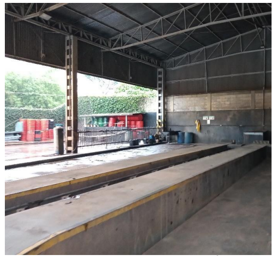
Figura 140 - Ponto de Troca de Óleo.
