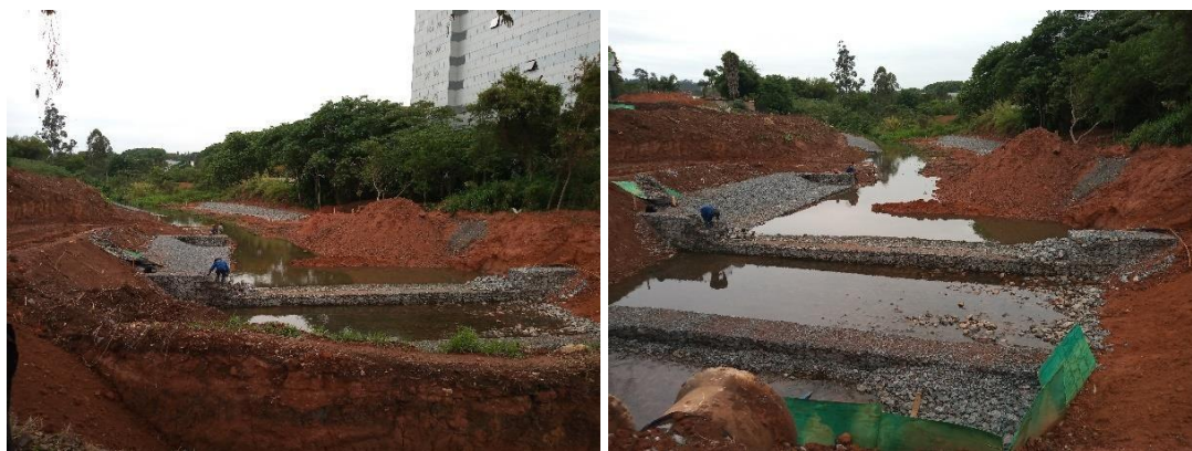
Figura 180 – Obra de implantação de sistema de retenção de sólidos a montante do Lago do Taboão
