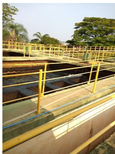
Figura 30 – Referente aos coletores de água decantada
