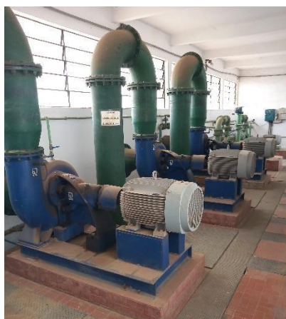
Figura 40 e 41 – Referentes a Casa de Bombas da ETA (Lavagem de filtros)
