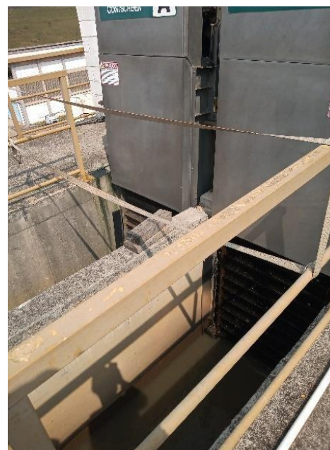
Figura 115 - Gradeamento Mecânico (1 em operação e 1 reserva)
