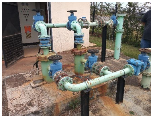
Figura 46 – Elevatória com pelo menos 2 bombas, sendo 1 reserva
