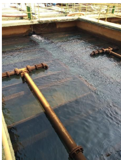
Figura 30 – Referente aos coletores de água decantada
