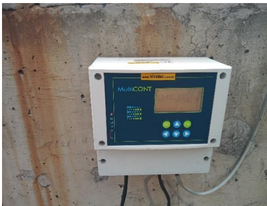
Figura 118 - Medidores de Vazão Ultrassônicos.
