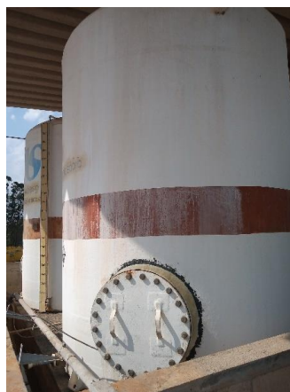
Figura 125 - Armazenamento de Hipoclorito de Sódio.
