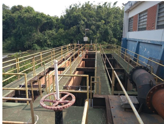
Figura 20 - Captação possui crivo, gradeamento e caixa de areia.
