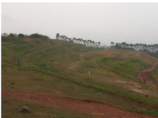
Figura 166 -Vista geral do aterro sanitário encerrado.
