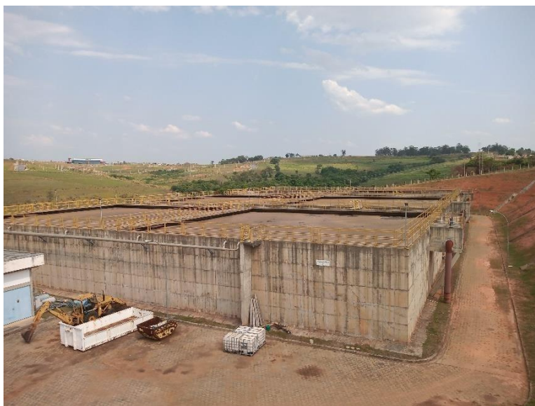
Figura 121 - 3 Tanques de aeração com injeção de ar através dos sopradores. (aeração prolongada com entrada de lodo ativado e sem necessidade de limpeza de lodo.
