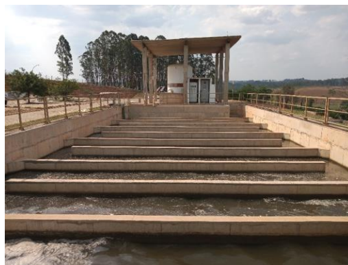
Figura 123 - Tanque de Contato com adição de Hipoclorito de Sódio
