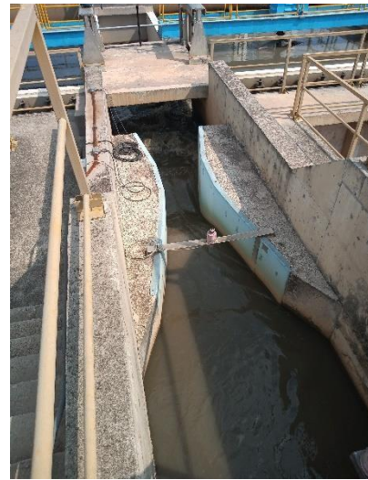
Figura 117 - Calha Parshall
