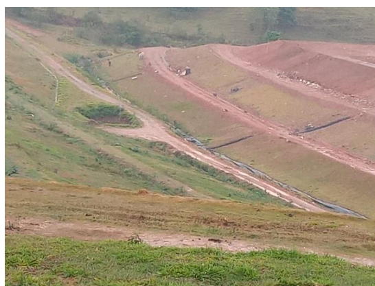
Figura 169 - Sistema de coleta de águas pluviais e chorume.
