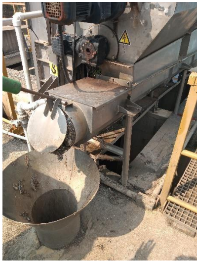
Figura 116 - Compactador do material gradeado
