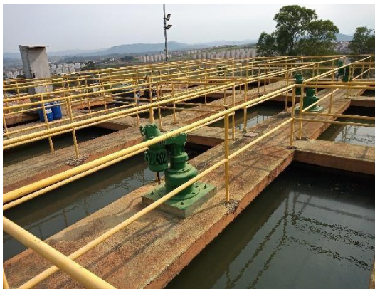
Figura 27 – Apresenta o 1º Módulo Floculador.
