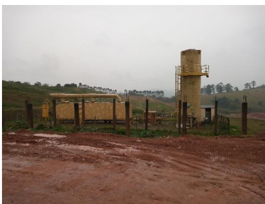
Figura 170 - Extração forçada de gás.
