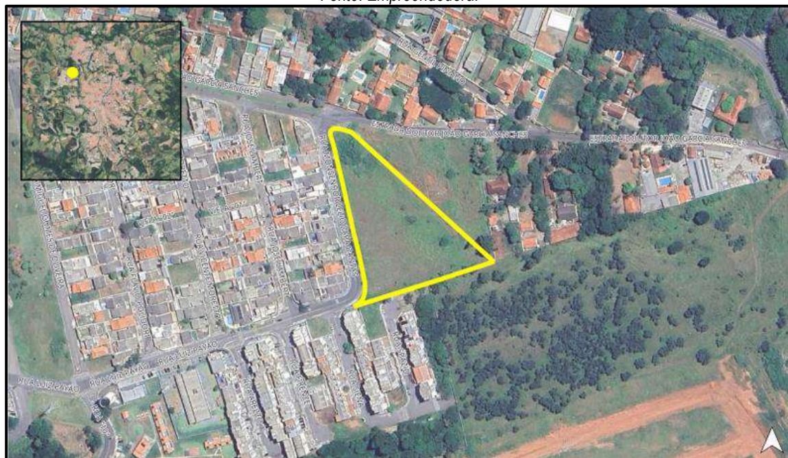
Registro fotográfico 1: Situação atual do terreno em que será implantado o empreendimento.
