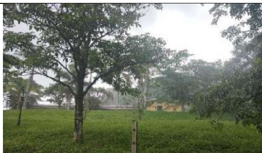
Figura 30. Edificação principal ( sede ) próxima à ADA do empreendimento, na AVI.
