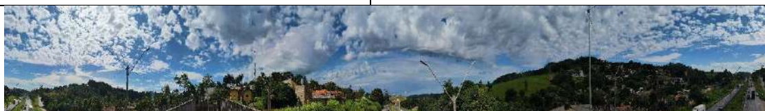
Figura 5. Visão panorâmica do entorno da Rodovia Fernão Dias (SP – 010), sentido Bragança Pta na AVM.
