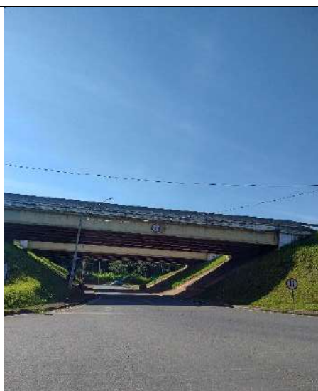
Figura 13 Visão parcial do acesso pela Rodovia Fernão Dias (SP-010) que dá acesso direto para o empreendimento na AVI.
