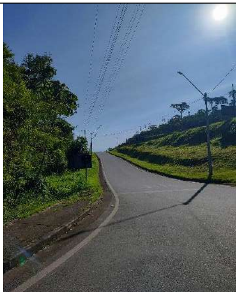
Figura 14. Visão parcial da Rodovia Fernão Dias (SP-010) que dá acesso direto para o empreendimento na AVI.
