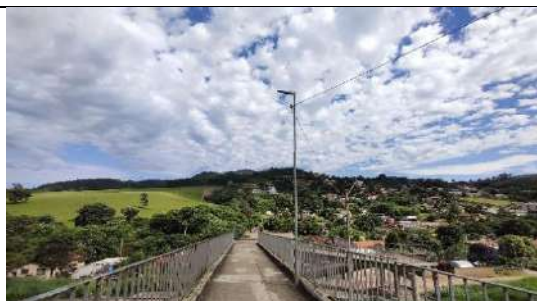
Figura 6. Pontilhão localizado na AVM, onde está localizada nas proximidades um ponto de ônibus.
