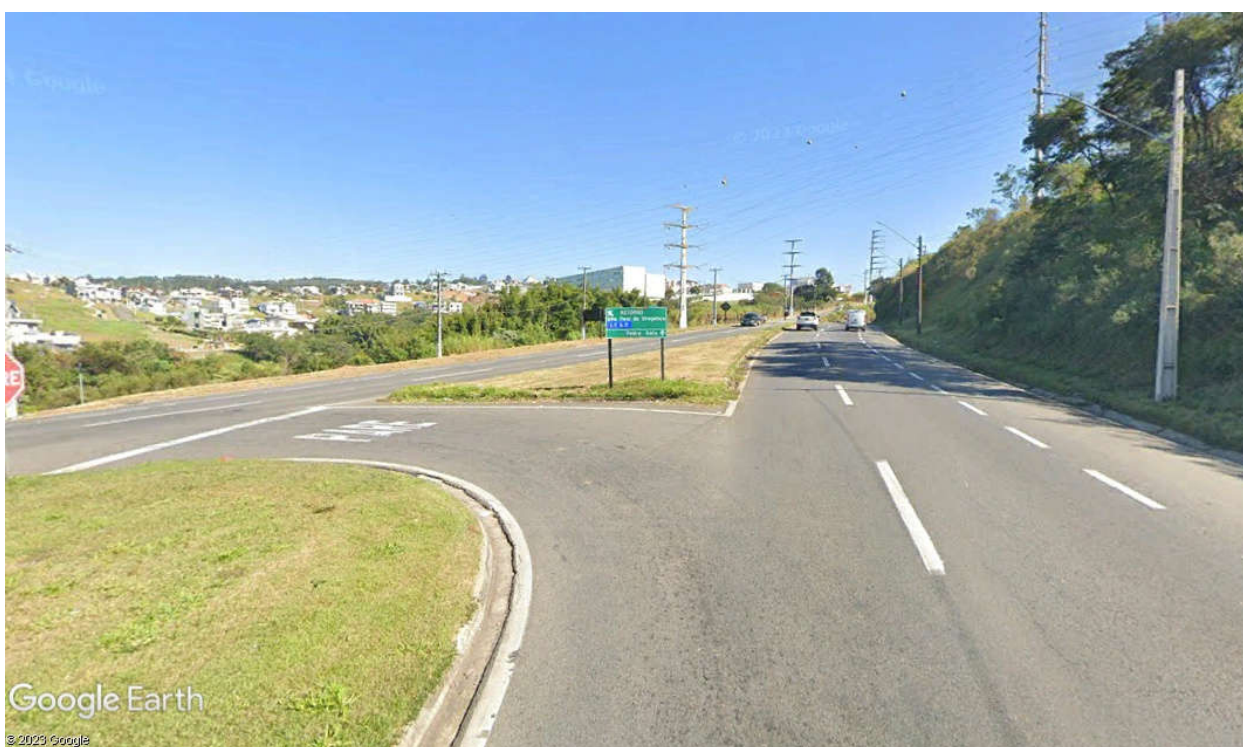
FOTO 1 – Av. Plínio Salgado, com acesso a Av. Villa Real, seguindo pela Rua Sergipe, no trecho de acesso ao sistema viário do entorno analisado (Fonte: Google Earth).
