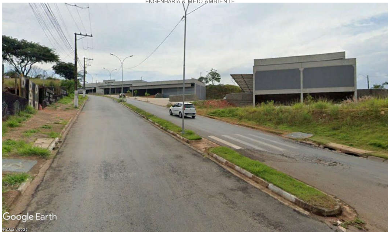
FOTO 02 – Vista parcial da vizinhança imediata (Fonte: Google Earth).
