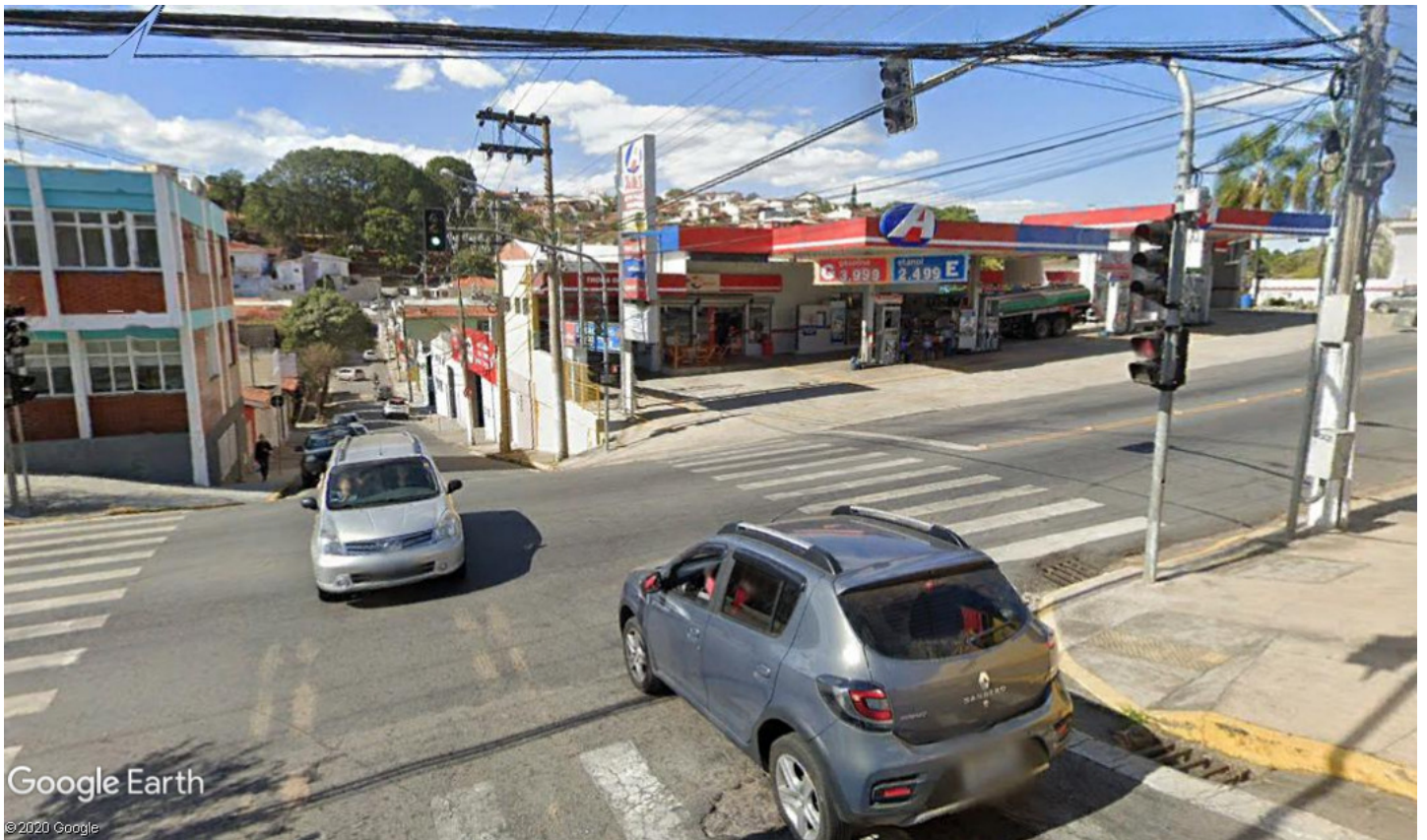
FOTO 04 – Vista do entorno (vizinhança mediata) a partir da confluência da Av. Antônio Pires Pimentel com a Rua da Liberdade (FONTE: Google Earth).
