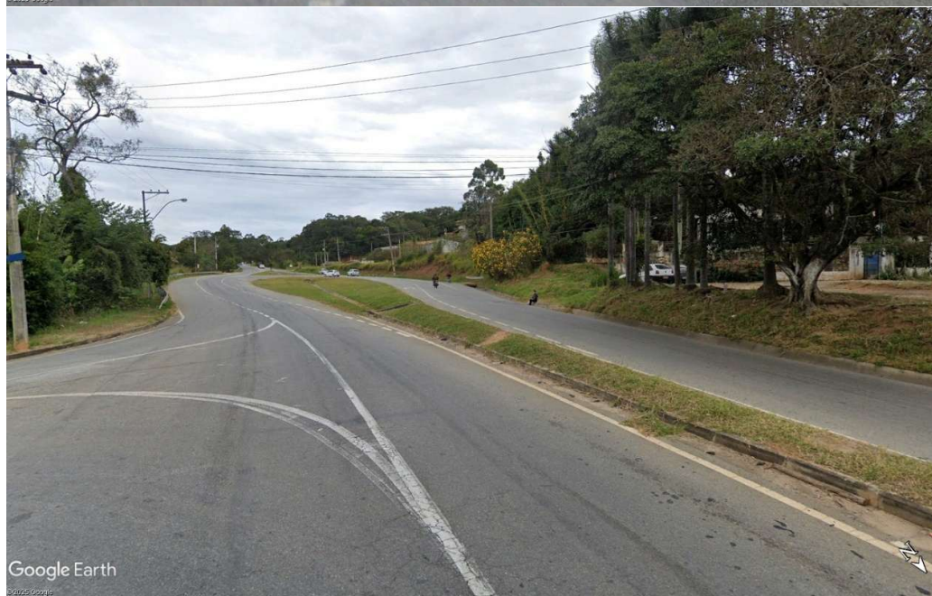
FOTOS 3 e 4 – Segundo trevo de acesso/retorno, pelos dois sentidos. (Fonte: Google Earth).
