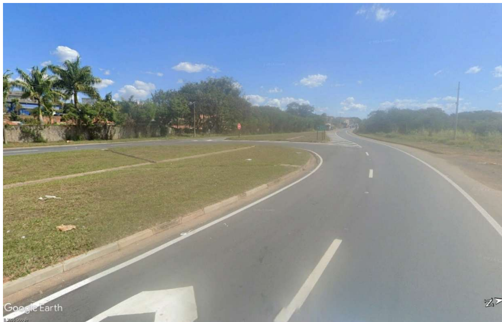
FOTO 1 – Primeira parte do primeiro trevo de acesso/retorno, para quem trafega no sentido bairro-centro (Fonte: Google Earth).
