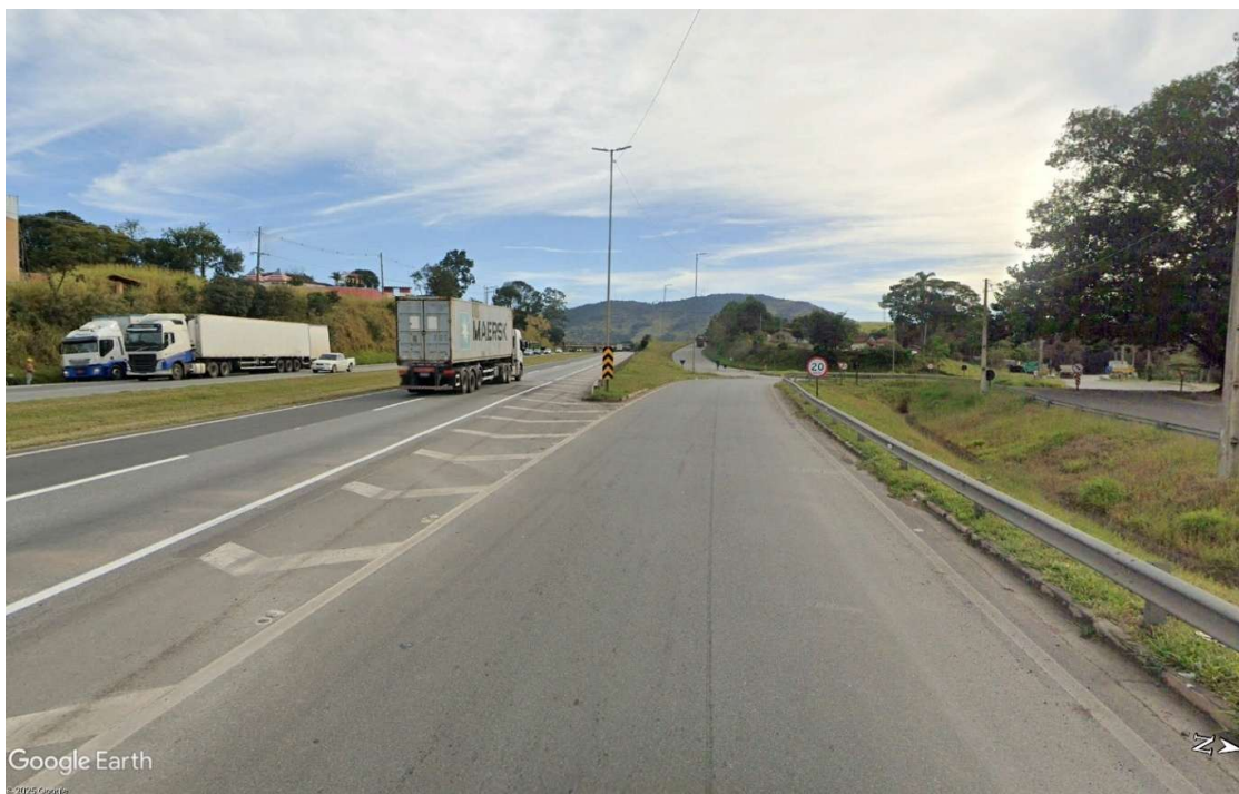
Foto 7 – Interligação da Rodovia João Hermenegildo de Oliveira (SPA-009/010) à Rodovia Fernão Dias (BR-381) (FONTE IMAGEM: Google Earth).
