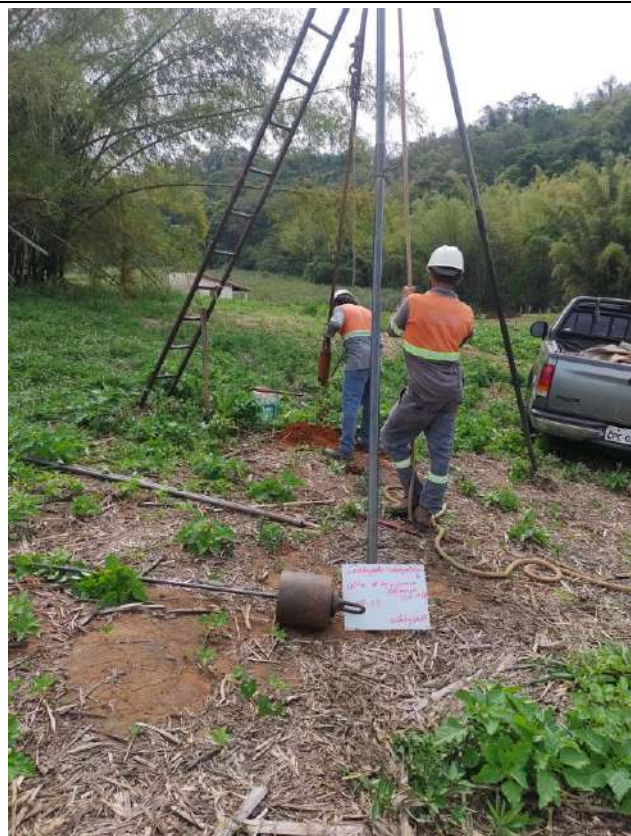
FOTO 06- Visada leste/oeste - SPT -03
