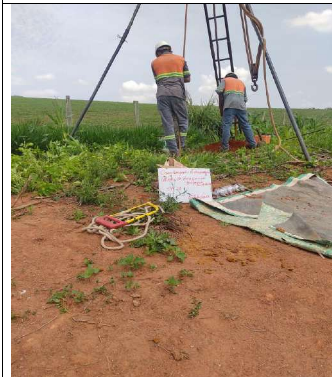
FOTO 04- Visada leste/oeste - SPT-01
