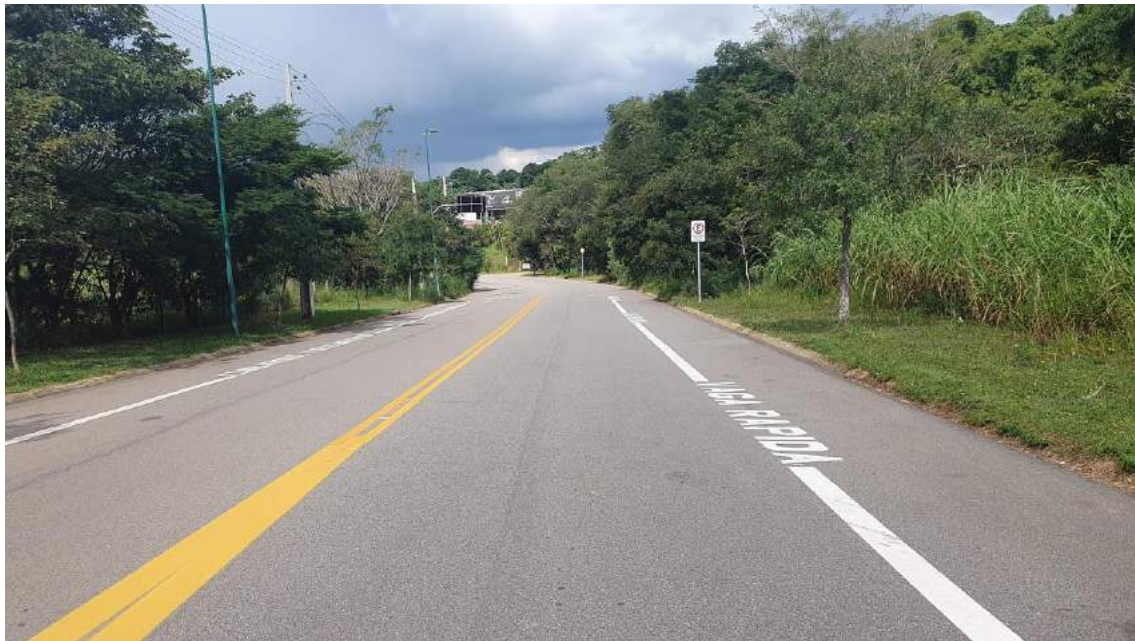
Foto 17 - Área de vizinhança mediata. A Alameda Horizonte apresenta boa sinalização horizontal e vertical, bem como boa conservação de seu pavimento asfáltico.
