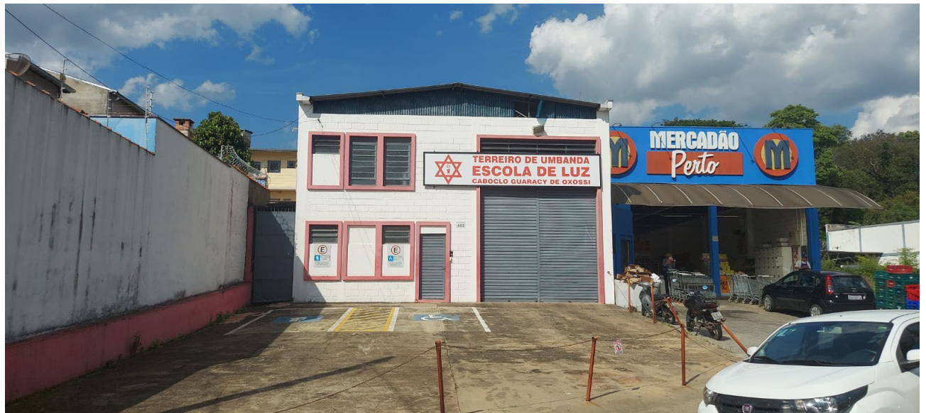
Fachada do prédio – foto tirada pelo arquiteto
