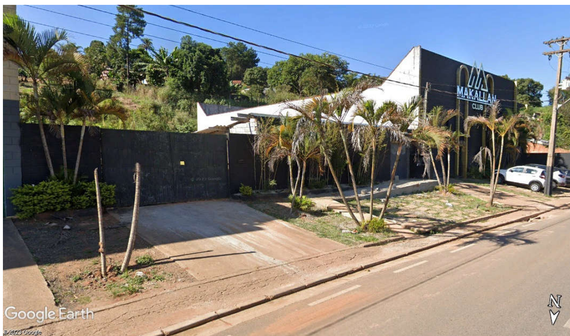
FOTO 02 – Fachada e estacionamento para a Rua das Esmeraldas. (FONTE: Google Earth).
