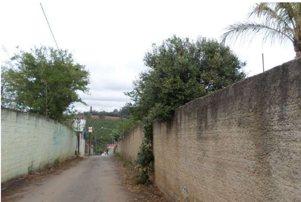
Foto 20. Ausência de Passeios Públicos, Núcleo Informal Paiolzinho.
