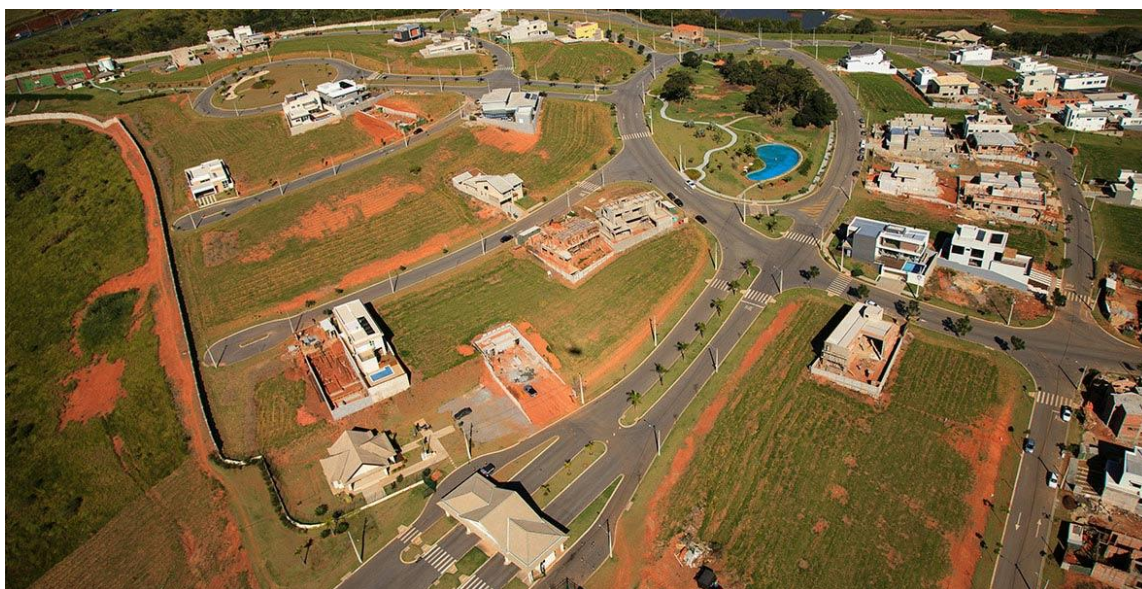
Figura 3.2.3-9: Exemplo de uso residencial com lotes vazios, no compartimento 1 (Condomínio Portal de Bragança Horizonte)
