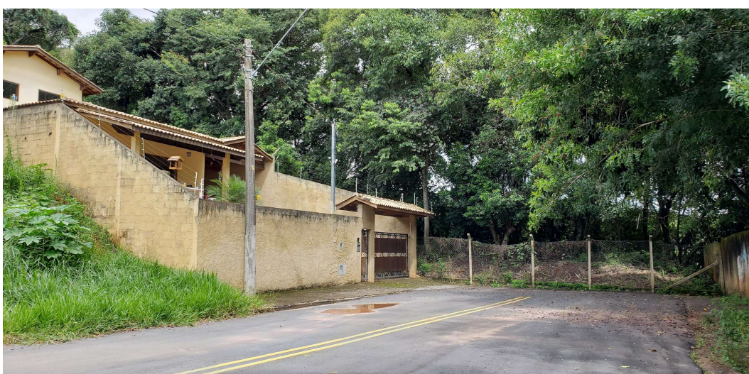
Foto 04: Fundos do imóvel para a Rua 07 de Setembro.
