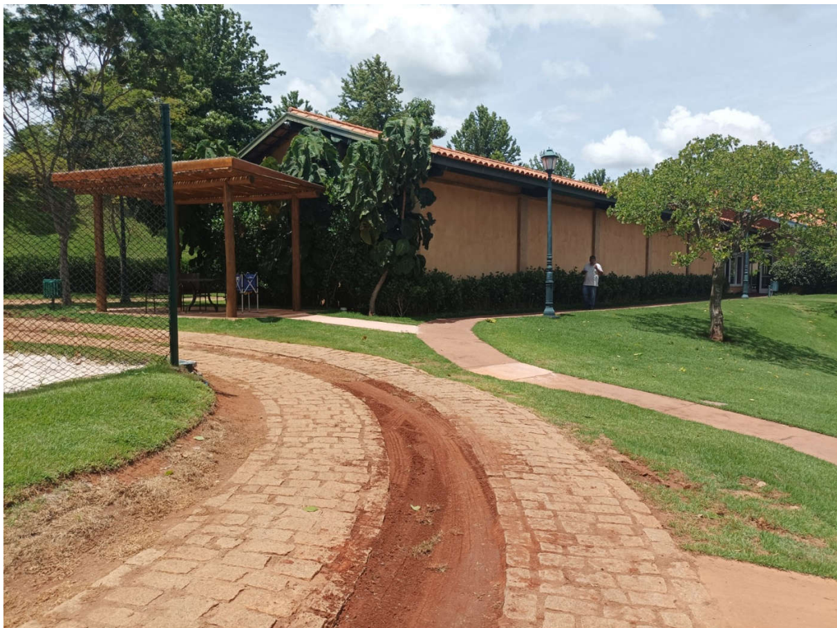
FOTO 07 – Vista de pergolado aos fundos do edifício multiuso.
